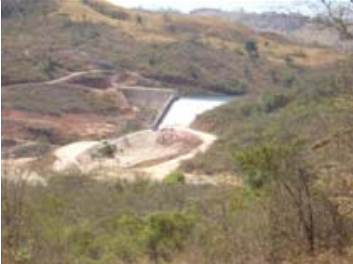
Foto 11. Pequena Central Hidrelétrica – Goiandira, em funcionamento.
