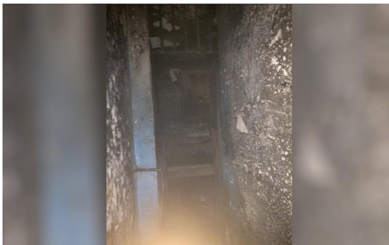
Alojamento ficou destruído após incêndio, em Goiânia — Foto: Reprodução/TV Anhanguera
