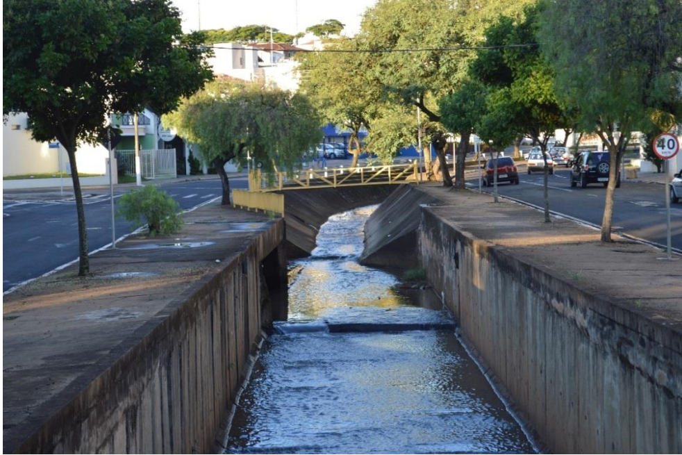
Foto 6 - Aspectos atuais da canalização do córrego Cubatão, em Franca (SP)
