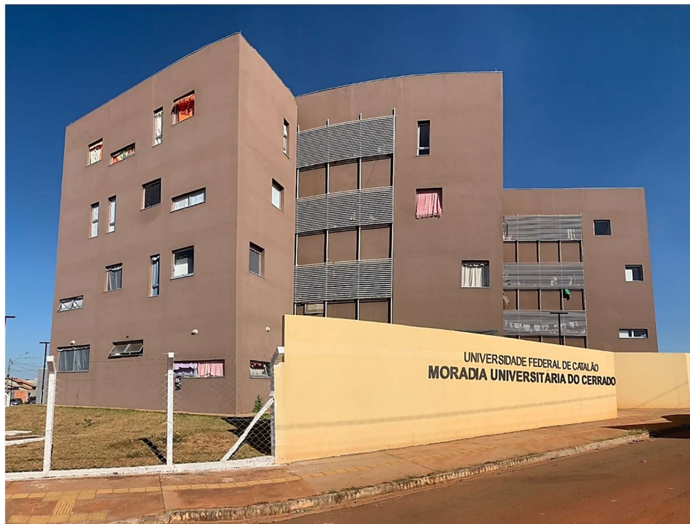
Figura 6 - Fachada da Moradia Universitária do Cerrado (MUC)
