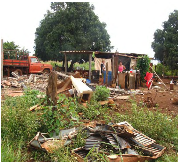
Foto 11 – Restos de casa destruída, área ocupada na fazenda Santa Juliana, município de Bom Jesus (GO). Autor: BUNDE, A., fevereiro/2011.
