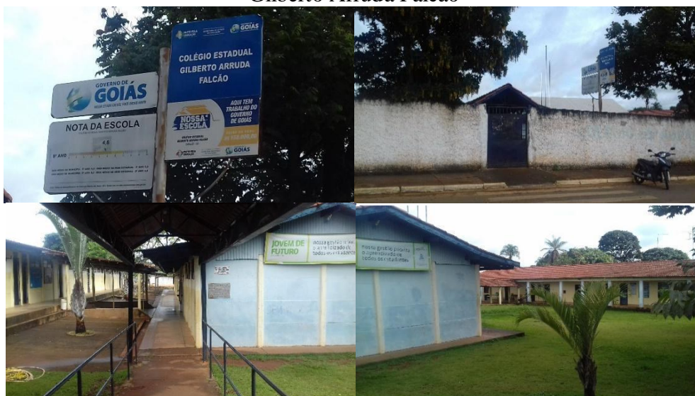
Foto 19: Distrito Sto. Ant. do Rio Verde, Catalão-GO - Instalações do Colégio Estadual Gilberto Arruda Falcão
