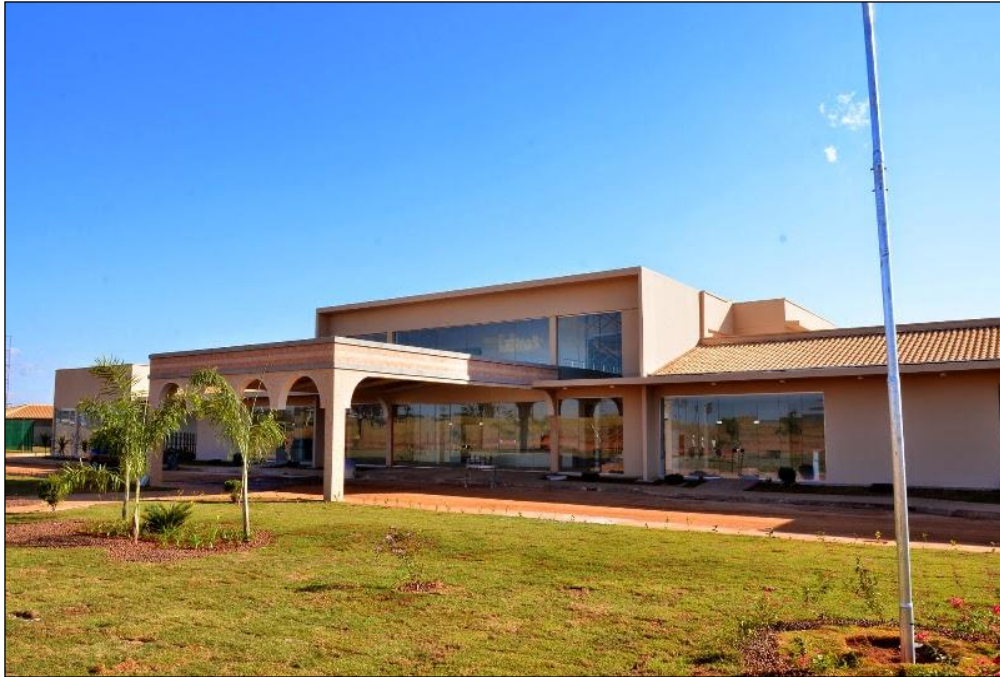
Foto 2 - Vista da fachada da unidade do CREDEQ, de Aparecida de Goiânia.
