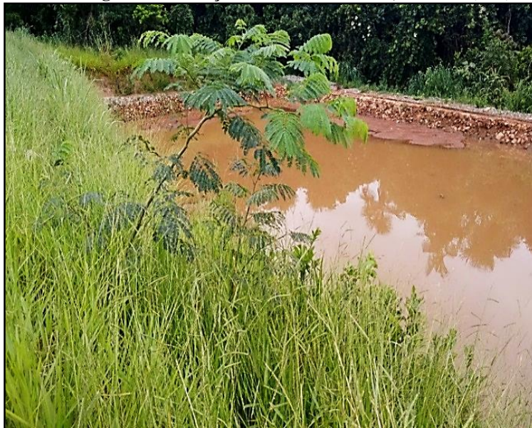
Foto 22 - Lagoa de contenção na área de Vereda, Catalão (GO)
