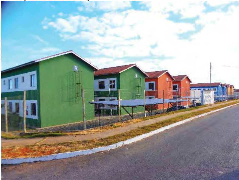
Foto 20: Conjunto habitacional Ipanema
