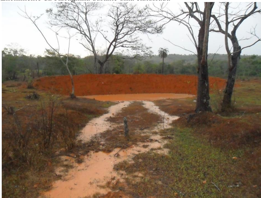
Figura 18 - Enchimento da barraginha durante uma enxurrada
