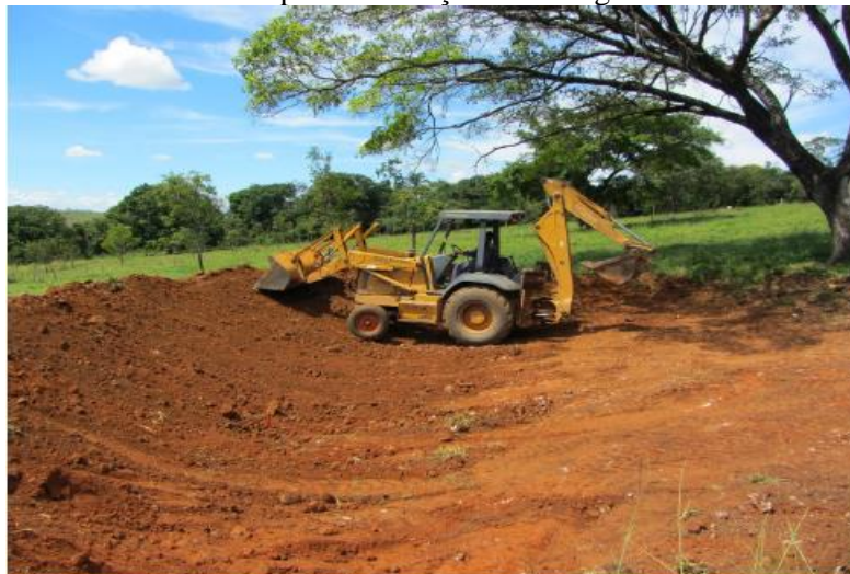
Figura 20 - Retroescavadeira utilizada para construção de barraginhas
