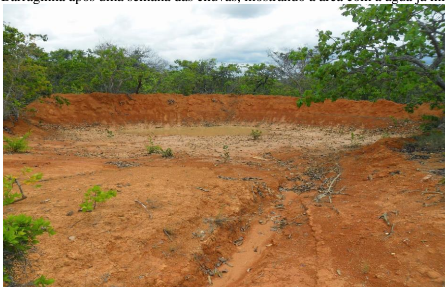
Figura 17 - Barraginha após uma semana das chuvas, mostrando a área com a água já infiltrada
