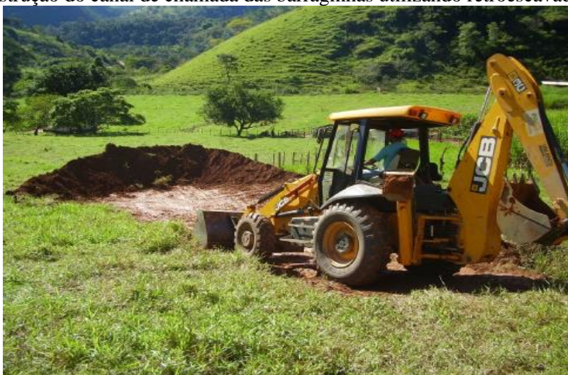
Figura 21 - Construção do canal de chamada das barraginhas utilizando retroescavadeira
