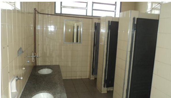
Foto 10 – Banheiro feminino da E. M. Profª Olga de Oliveira. Autora: Chumbinho, N.A.C.S. 01/20013
