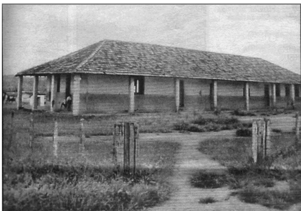
Figura 43: Grupo escolar - "Escola isolada da Fazenda da Barra"
