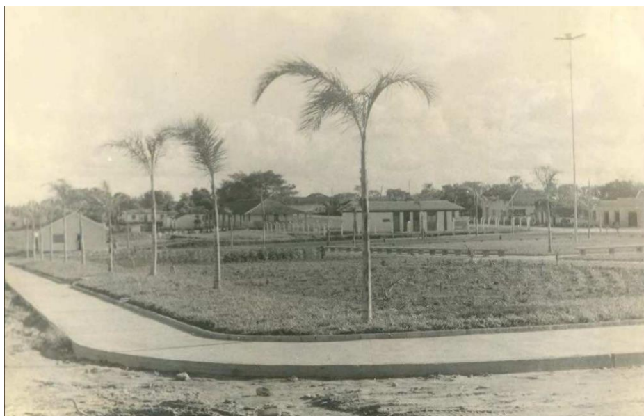
Figura 44: Construção da Praça Municipal Alto Paranaíba
