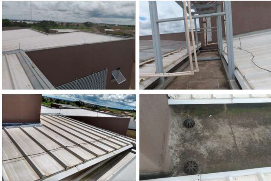
Figura 3.13 – Cobertura do edifício residencial da MUC/UFCAT
