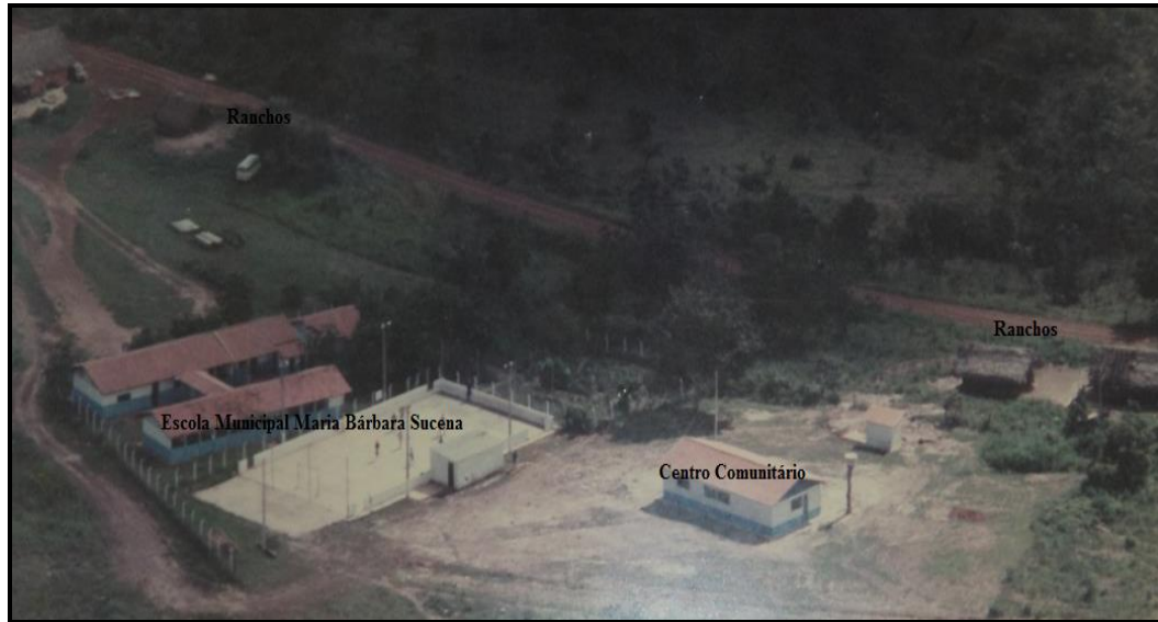
Figura 1: Localização dos Ranchos, da Escola Maria Bárbara Sucena e do Centro Comunitário da Comunidade Cisterna.
