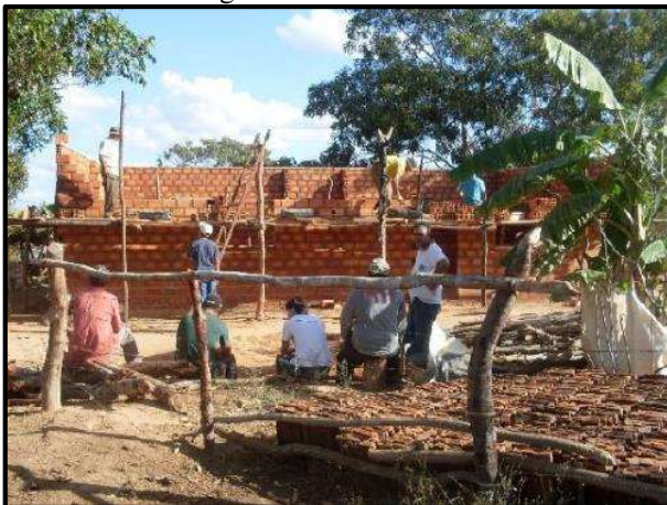
Foto 1 - Mutirão para construções de casas no Assentamento Olga Benário
