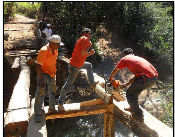
Foto 2 - Mutirão para construção de ponte no Assentamento Olga Benário
