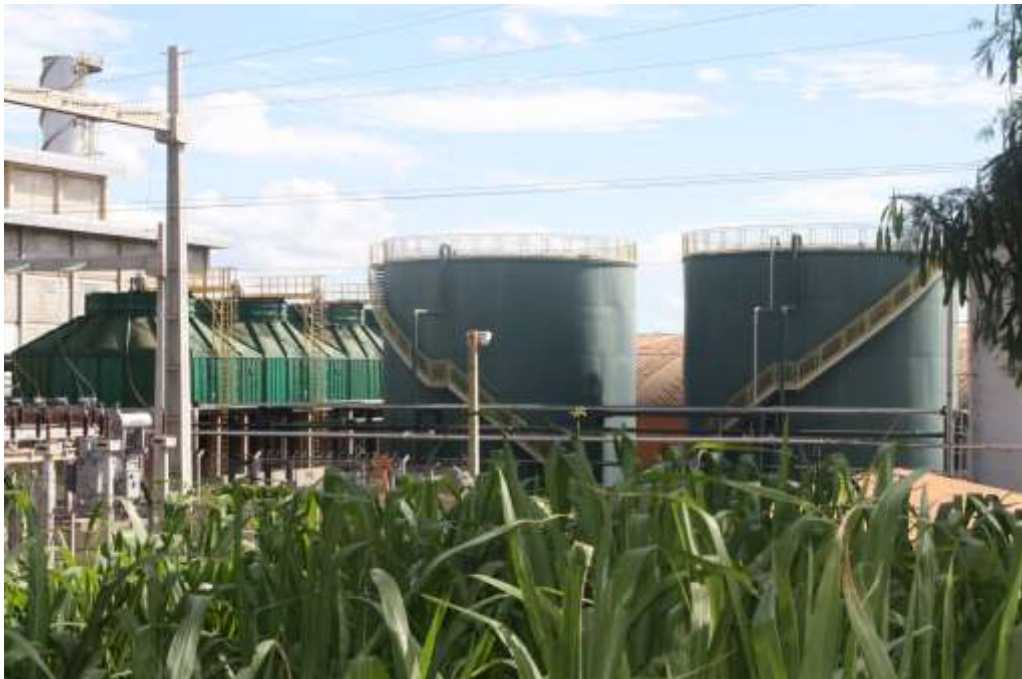
Fotografia 59 - Usina Alvorada. Araporã, Minas Gerais (2014)
