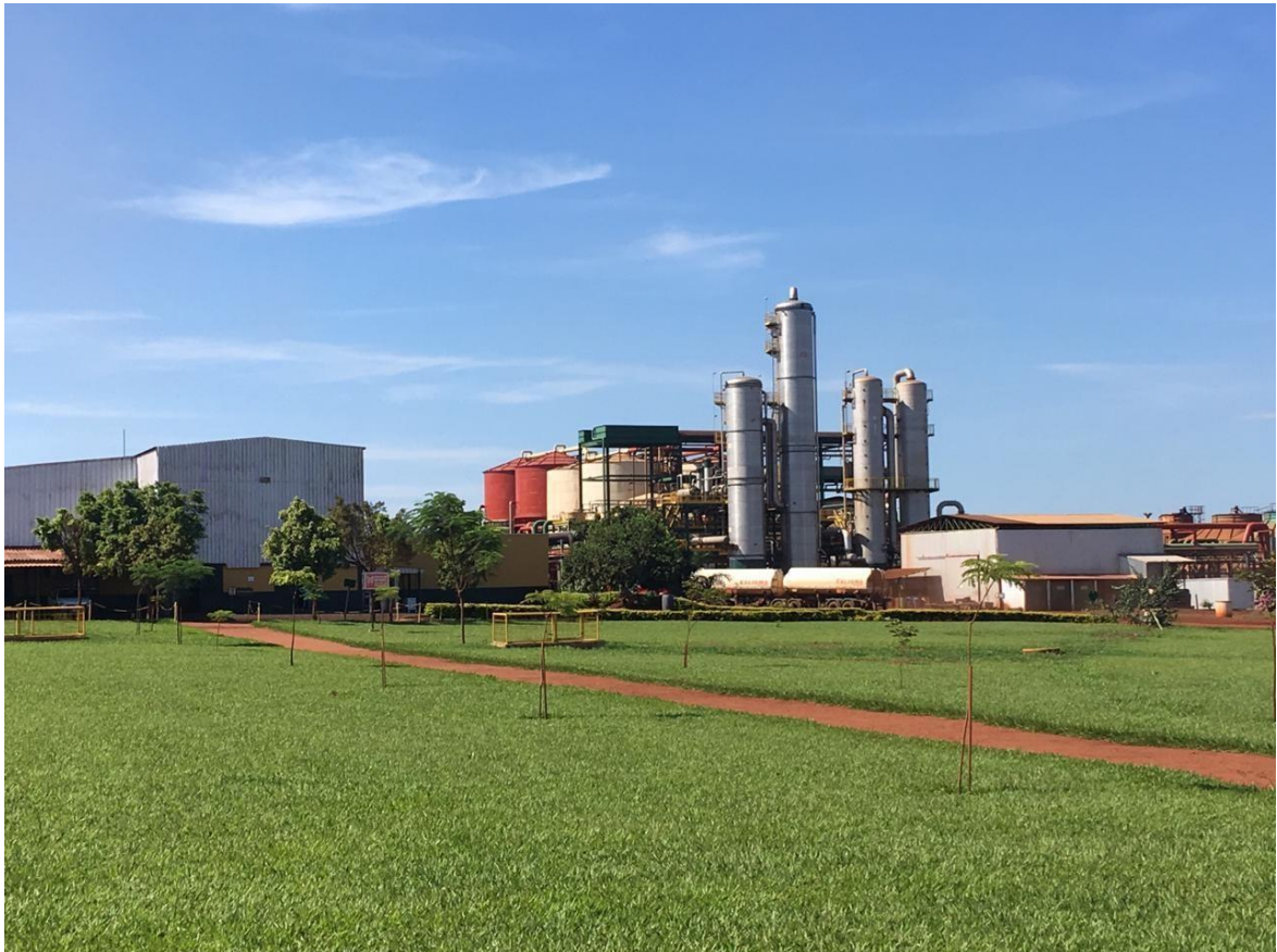
Foto 2 – Vista parcial da Usina Bom Sucesso em Goiatuba (GO)
