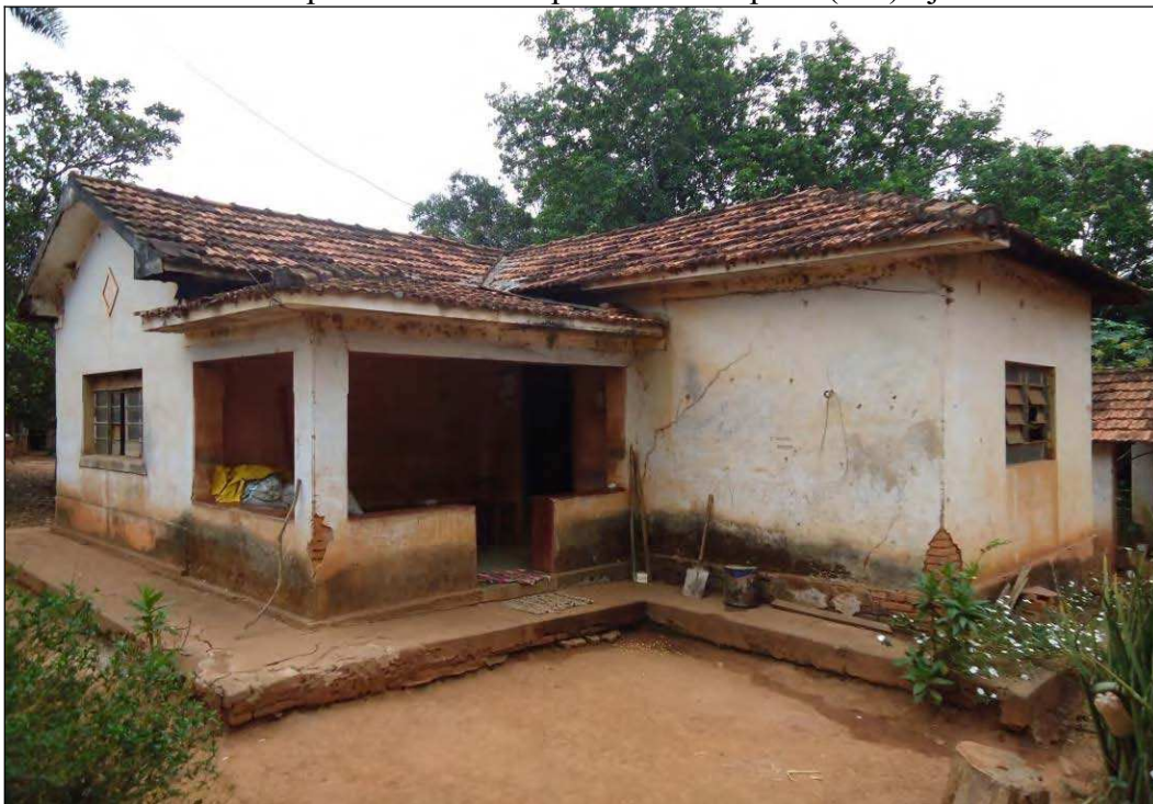
Foto 19: Casa com Alpendre no município de Davinópolis (GO) - jan/2011
