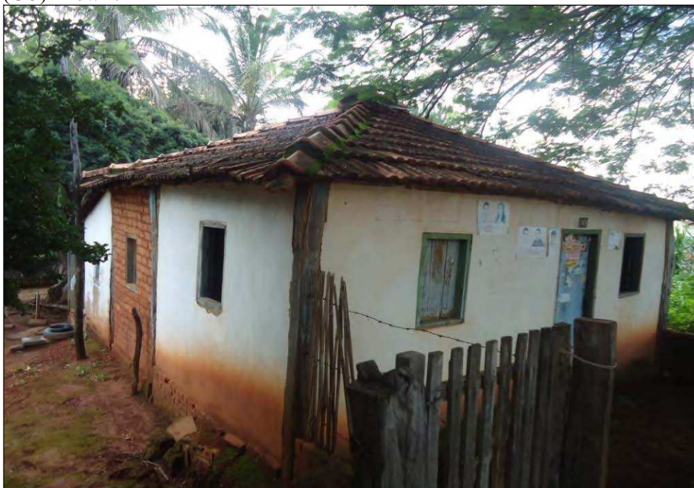
Foto 04: Primeira casa de Alvenaria construída no Povoado da Barra, Davinópolis (GO) - nov/2011
