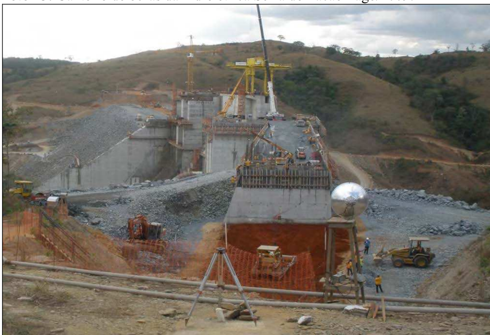
Foto 23: Canteiro de obras da hidrelétrica Serra do Facão - ago/2009.
