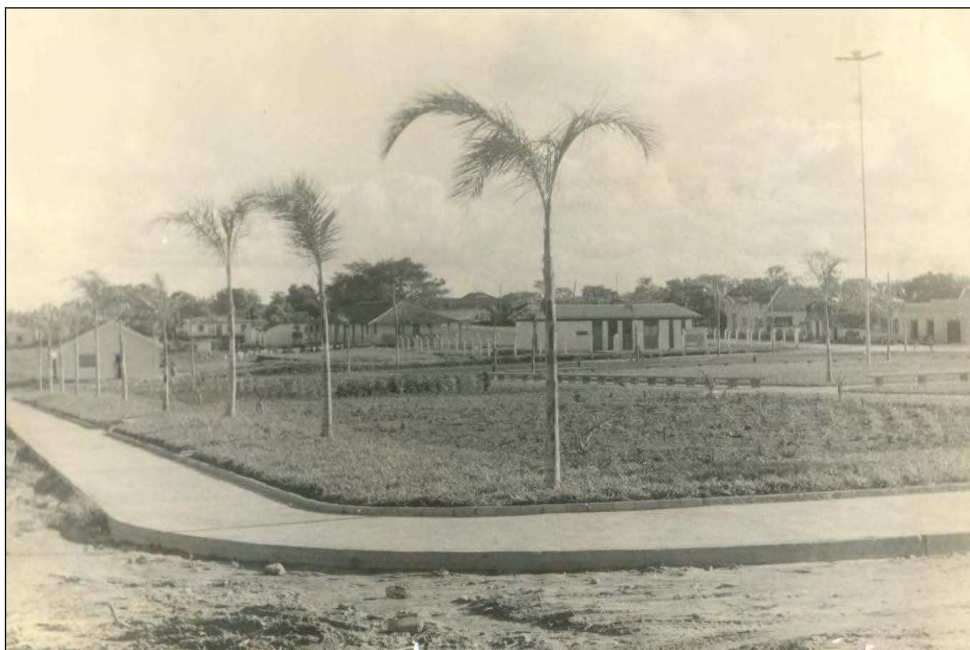
Foto 06: Construção da Praça Municipal Alto Paranaíba
