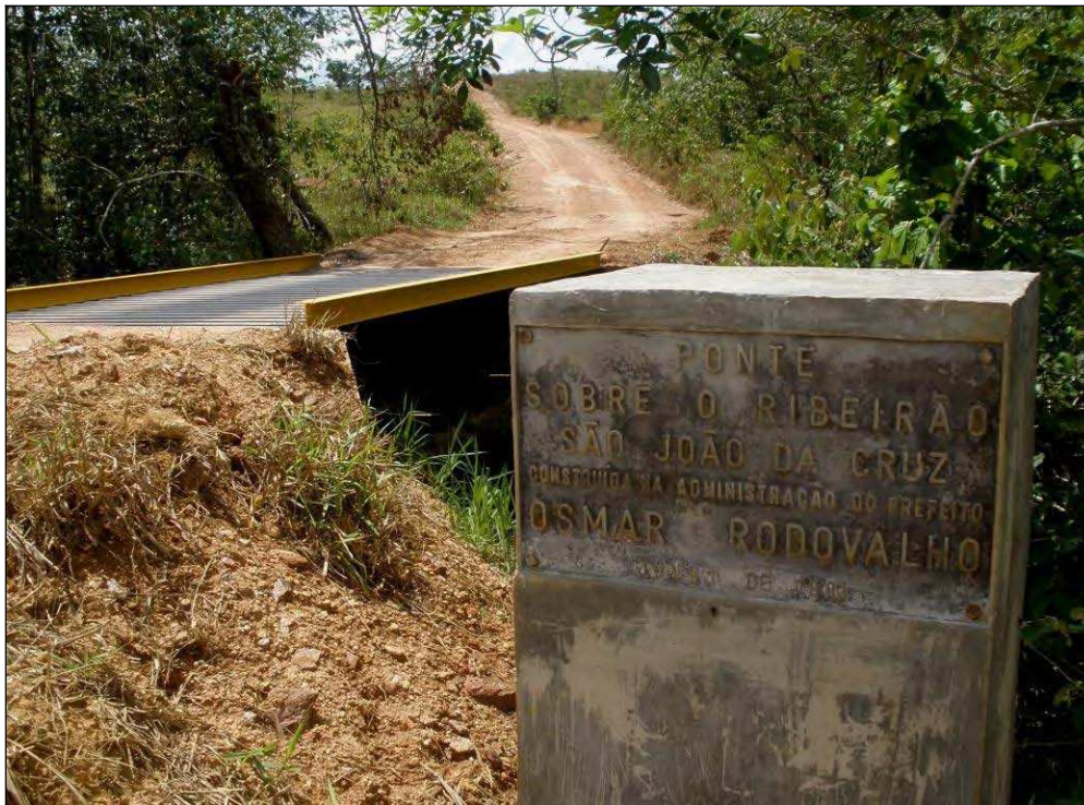
Foto 32: Ponte sobre o ribeirão São João da Cruz - out/ 2009.
