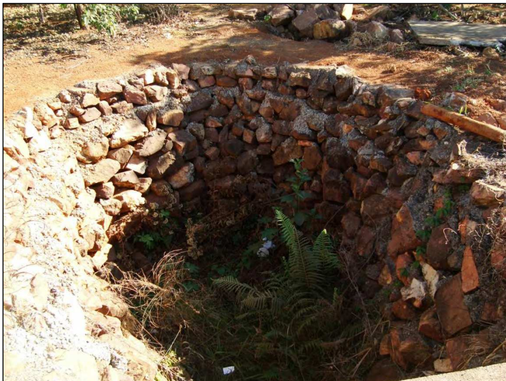
Foto 23 – Calçamento da Primeira Nascente do Ribeirão Pirapitinga. Autora: RIBEIRO, L. J. (2011).
