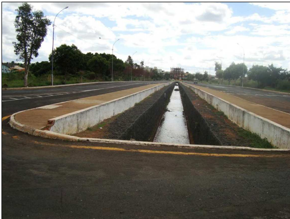
Foto 34 – Início da parte canalizada do Ribeirão Pirapitinga. Autora: RIBEIRO, L. J. (2010).
