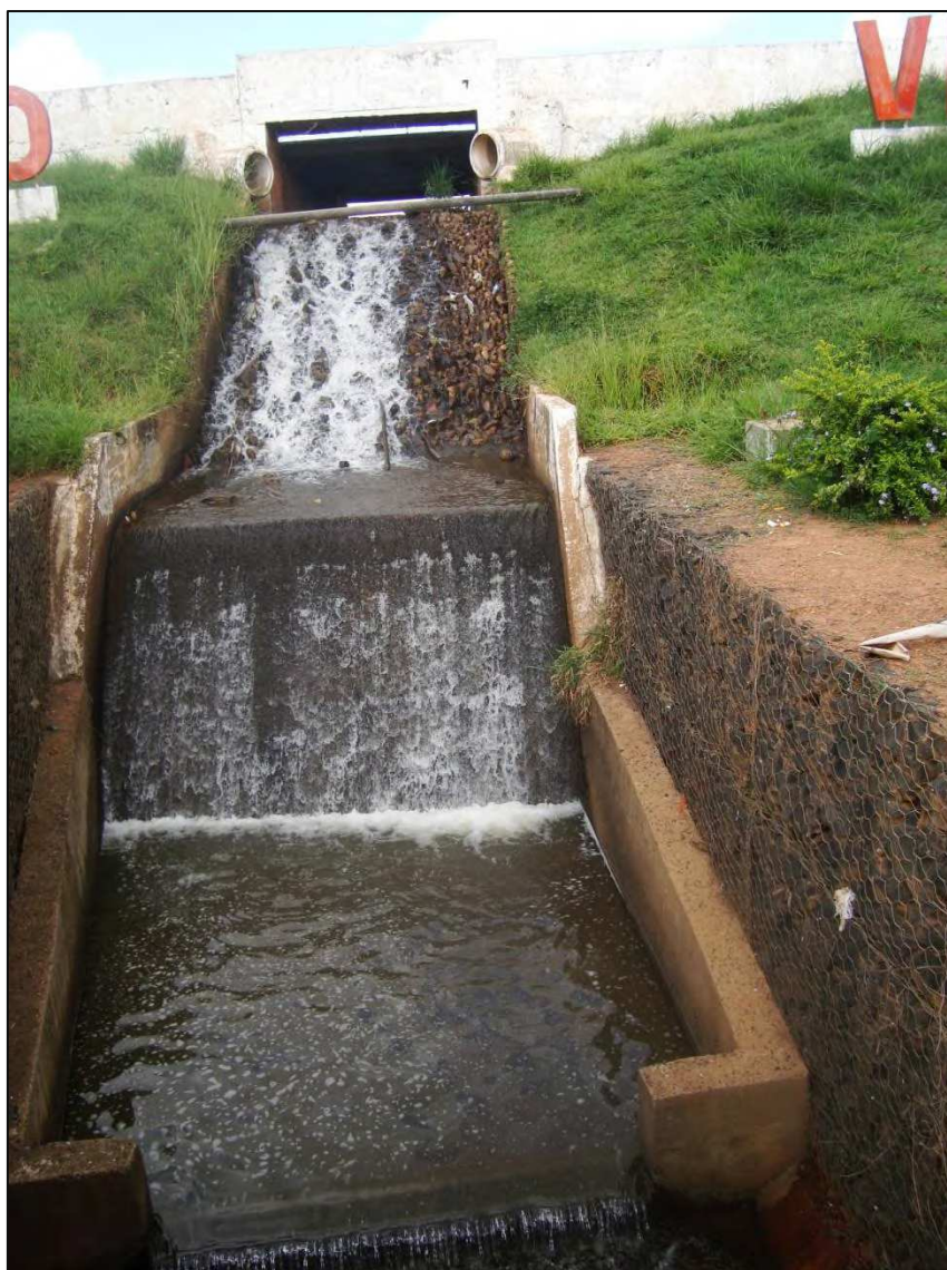
Foto 18 – Início da canalização do Ribeirão Pirapitinga – abaixo da Represa do Clube do Povo.
