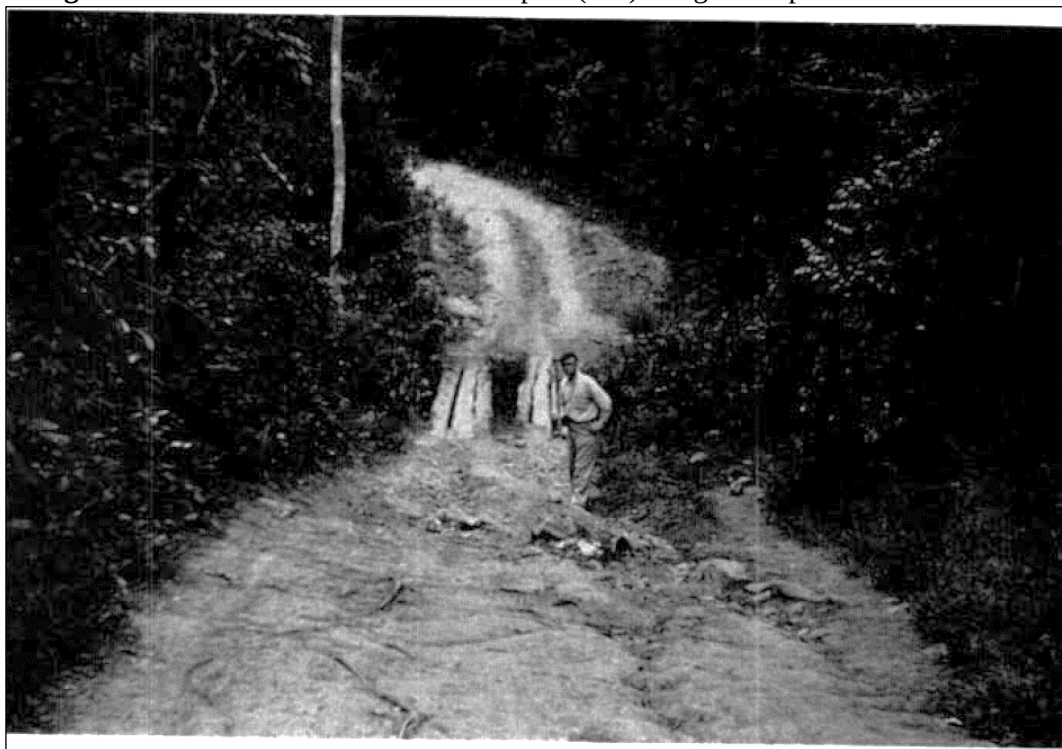
Figura 8: A velha estrada de acesso a Itapaci (GO) fotografada por Carmin em 1956.
