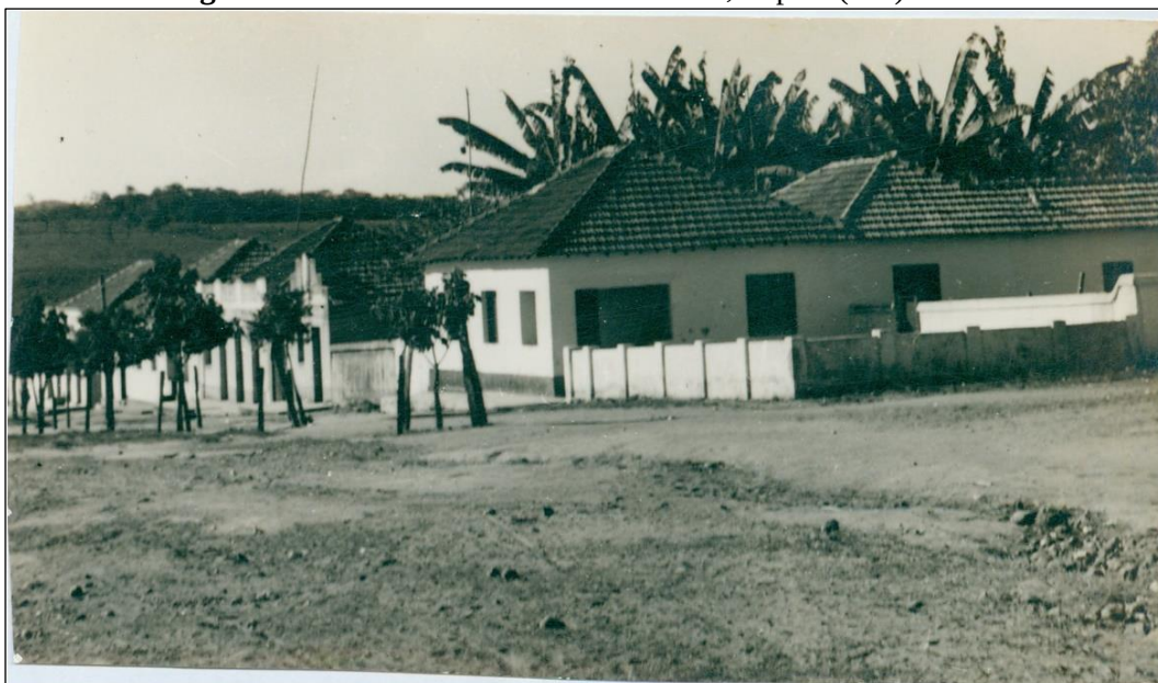
Figura 2: Residências na Avenida Floresta, Itapaci (GO) - 1958.
