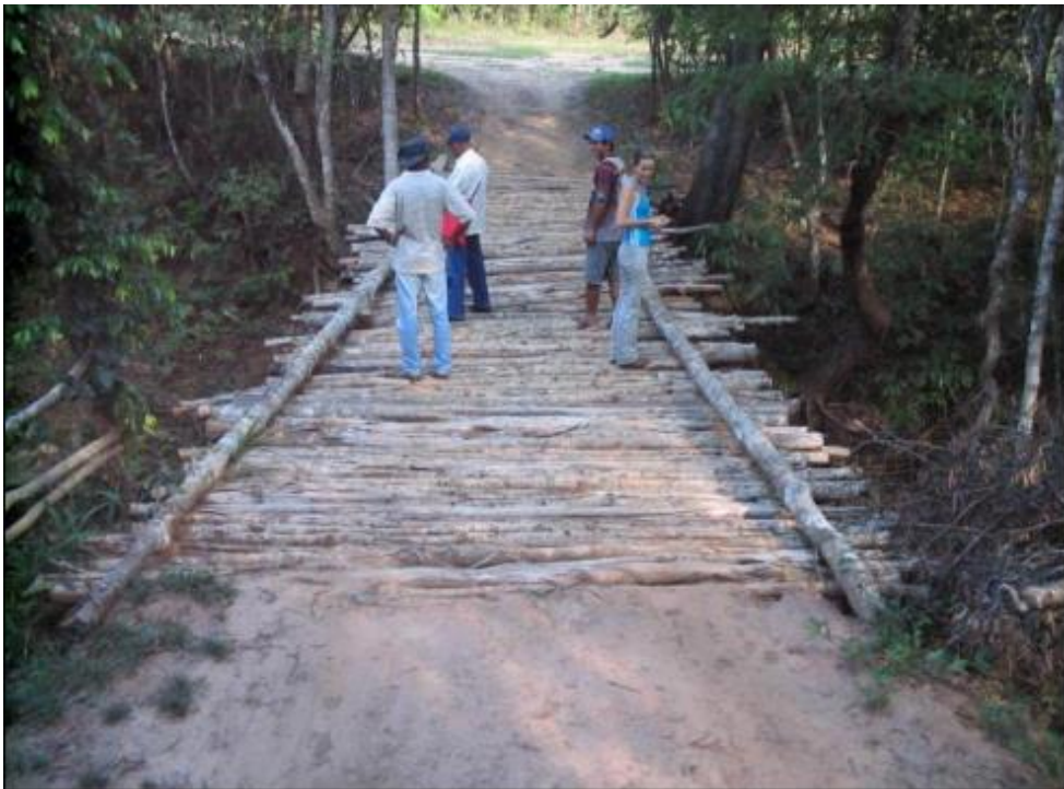
Foto 2 - Assentamento Olga Benário - Ponte construída sobre o Córrego das Nascentes em 2005
