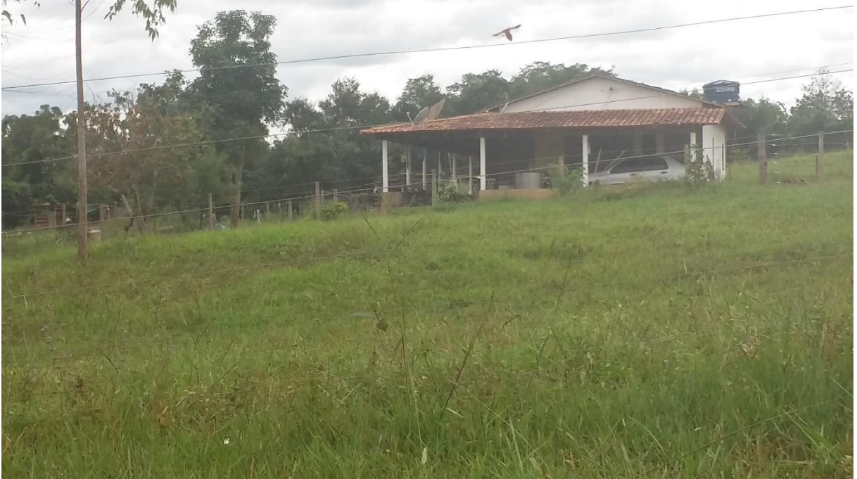
Foto 12 – Assentamento Olga Benário- Residência de alvenaria
