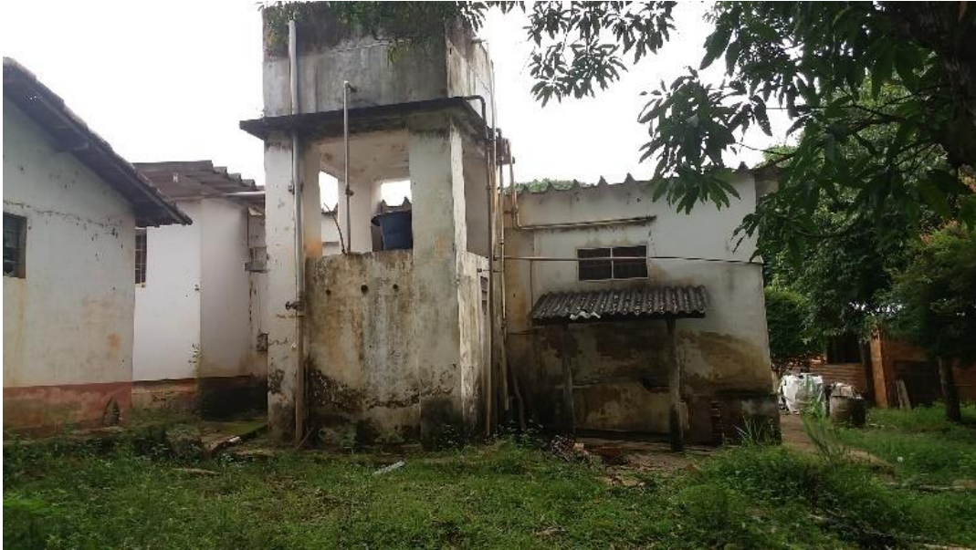
Foto 6 - Assentamento Olga Benário - Casa principal/ Área de serviço
