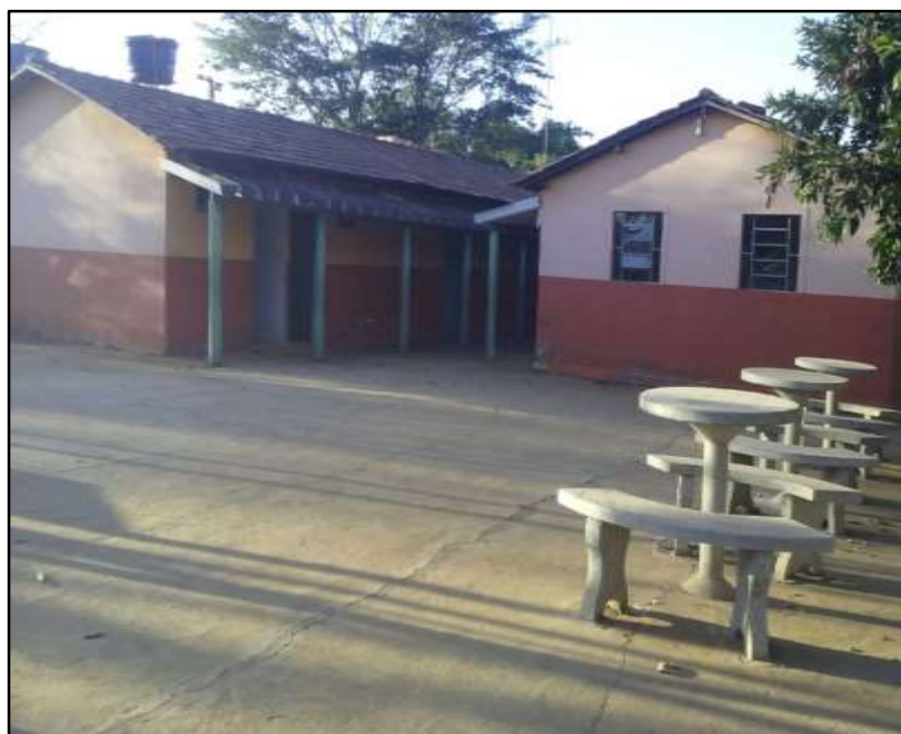
Imagem 7 – Foto da Escola Municipal Ana Cândida Vieira – Comunidade do Taquaral
