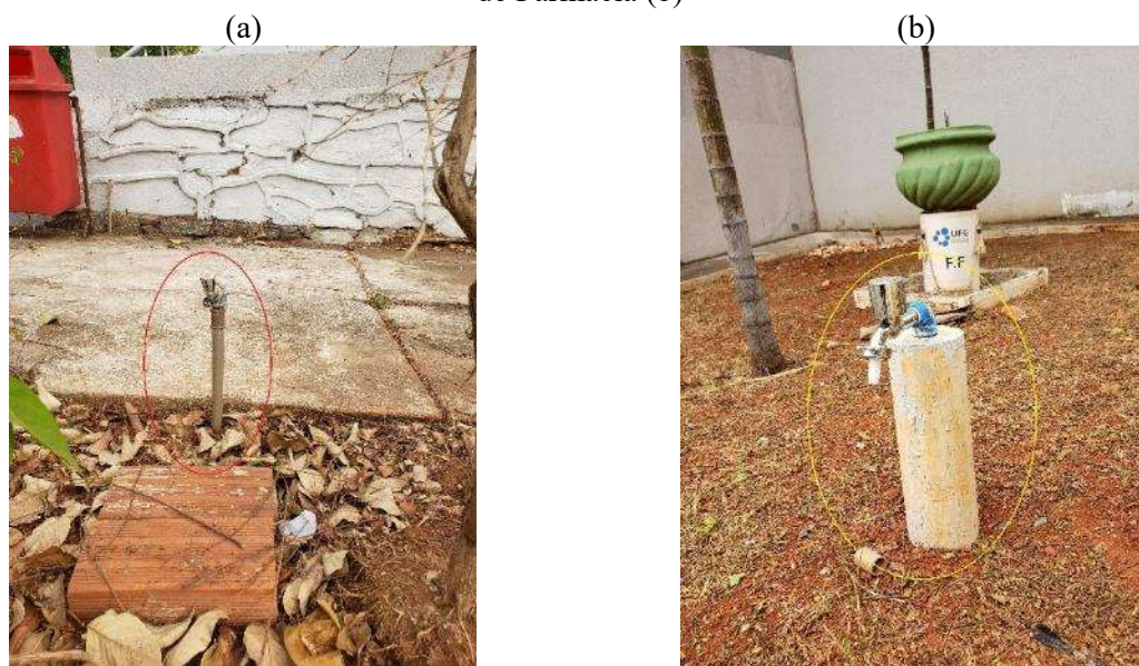
FIGURA 4.80 – Torneiras sem proteção no Museu Antropológico (a) e com proteção na Faculdade de Farmácia (b)
