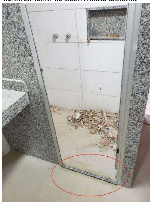
FIGURA 4.79 – Adaptação realizada em uma obra para contenção de água em sanitário sem detalhamento de declividade adotada
