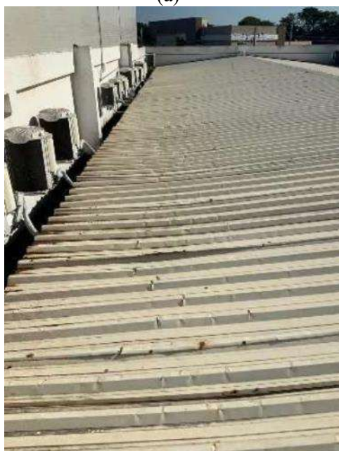
FIGURA 4.84 – Deficiências encontradas em sistemas de cobertura: telhas danificadas no caminho dos aparelhos de ar condicionado no Centro Regional para o Desenvolvimento Tecnológico e Inovação (a), escada apoiada sobre telhado na Faculdade de Educação (b) e aparelho de ar condicionado sobre telhado no Centro de aulas Baru (c)
