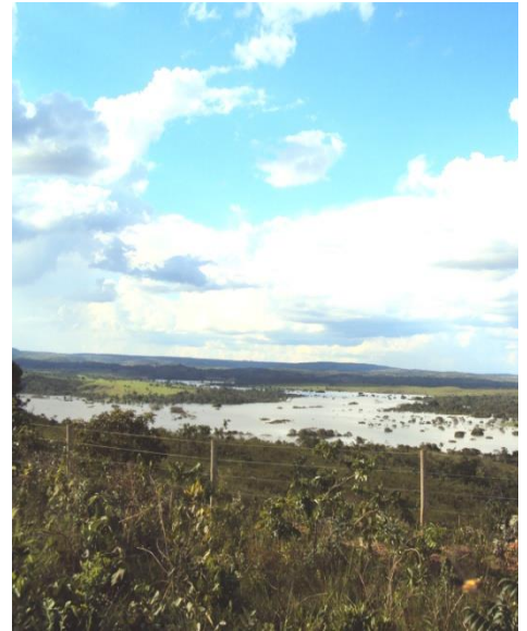
Foto 14 – Enchimento do reservatório da hidrelétrica Serra do Facão, município de Catalão (GO)
