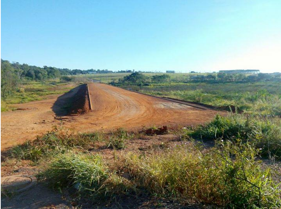
Fotografia 24 - Antigo Barramento utilizado na irrigação dos pivôs centrais, e que hoje possui um vertedouro para controle de vazão da água
