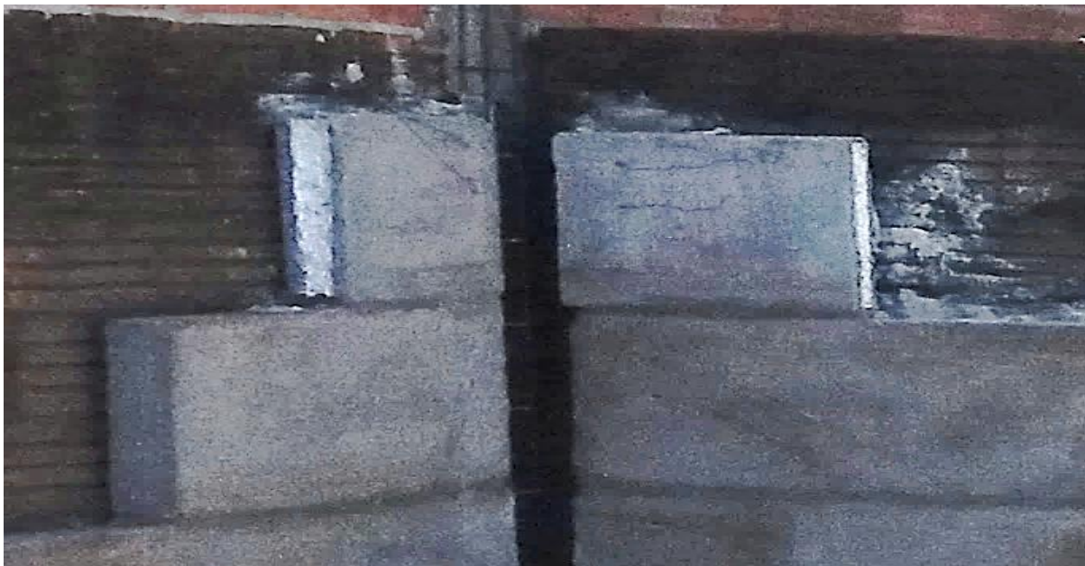
Figura 5 - Bloco de EPS revestido por concreto
