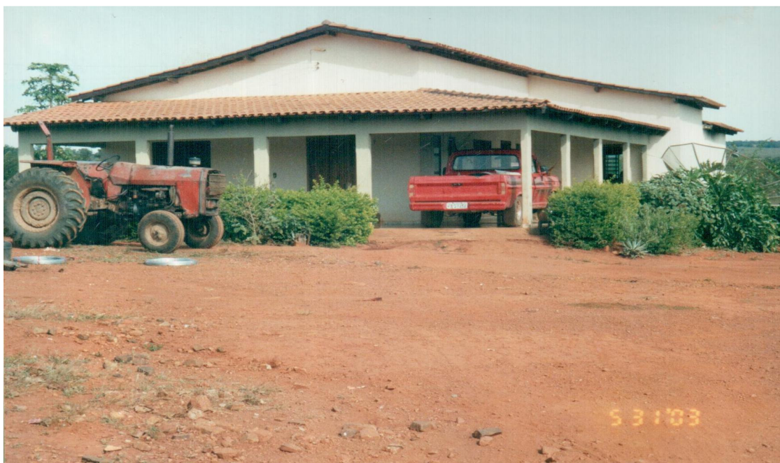
Figura Nº15: Residência camponesa na Comunidade Pires atingida por UHE Serra do Facão
