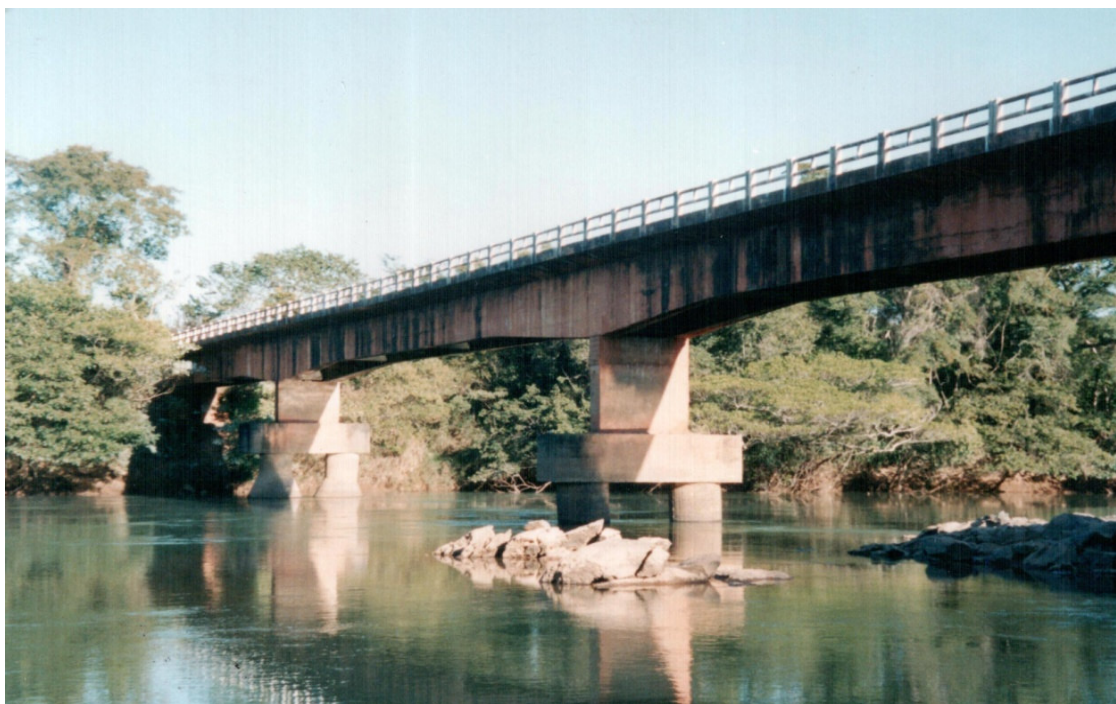
Autor: NAVES, J. C. Antiga ponte dos Carapinas em 05/06/2002
