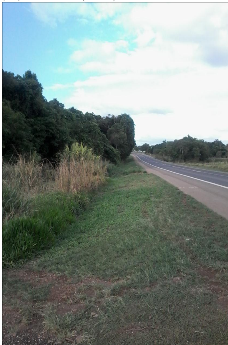
Foto 25 – Bacia Hidrográfica do ribeirão Samambaia/Catalão (GO): rodovia federal (BR-050) sobre uma nascente.
