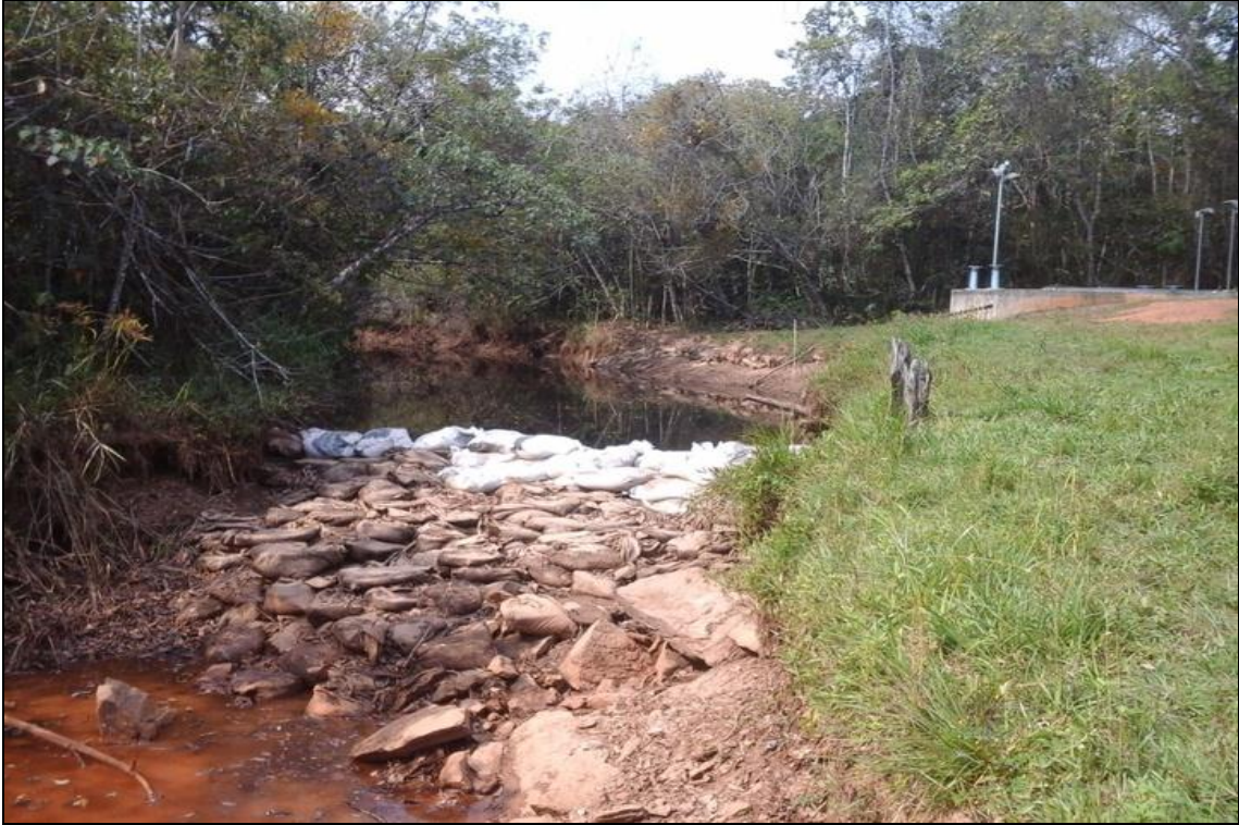
Foto 10 - Bacia Hidrográfica do ribeirão Samambaia/Catalão (GO): barramento com sacos de areia no leito do ribeirão Samambaia feito pela SAE.
