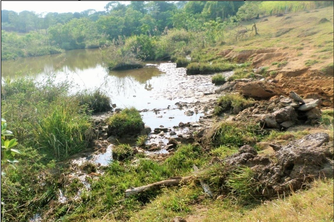
Foto 12 - Bacia Hidrográfica do ribeirão Samambaia/Catalão (GO): represa arrombada.
