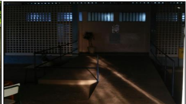
Figura 15 – Rampas de acesso do CERRC. Org: PINHEIRO, R. de A. Outubro/2016.
