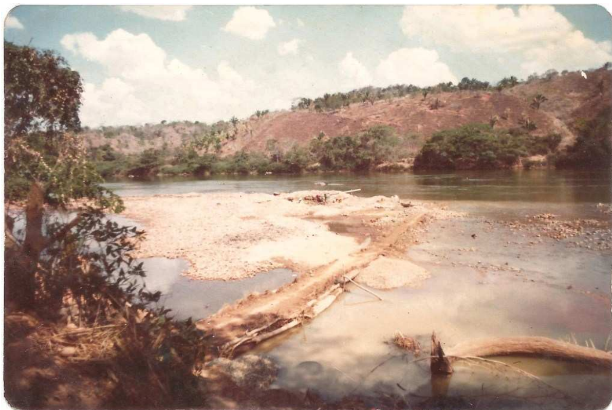
Figura 42 - Uma “virada”: parte do curso do rio é barrada e desviada, de maneira que o cascalho possa ser retirado. Era comum que o barramento rústico, feito com madeira e terra socada, se rompesse com a força das águas, destruindo o trabalho de muitos homens durante semanas. Bráulio Calaça conta que logo que começou a garimpar, perto dos seus 14 anos, assistiu a construção de uma virada que demorou dois meses e demandou o trabalho de mais de quarenta homens. Foto cedida pela S ra Maria Pereira Saldanha.
