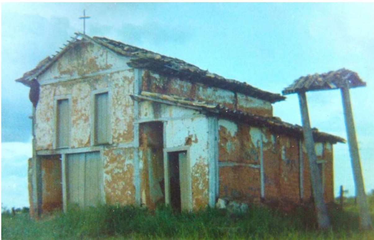
Figura10- Fotografada na década de 1970, a “igrejinha” de Nossa Senhora da Abadia, da qual hoje só restam os vestígios, foi construída bem próximo de onde está o centro urbano de Três Ranchos, no percurso da estrada do porto Mão de Pau para Catalão (Foto de Amadeu Francisco Soares, “Dil”).
