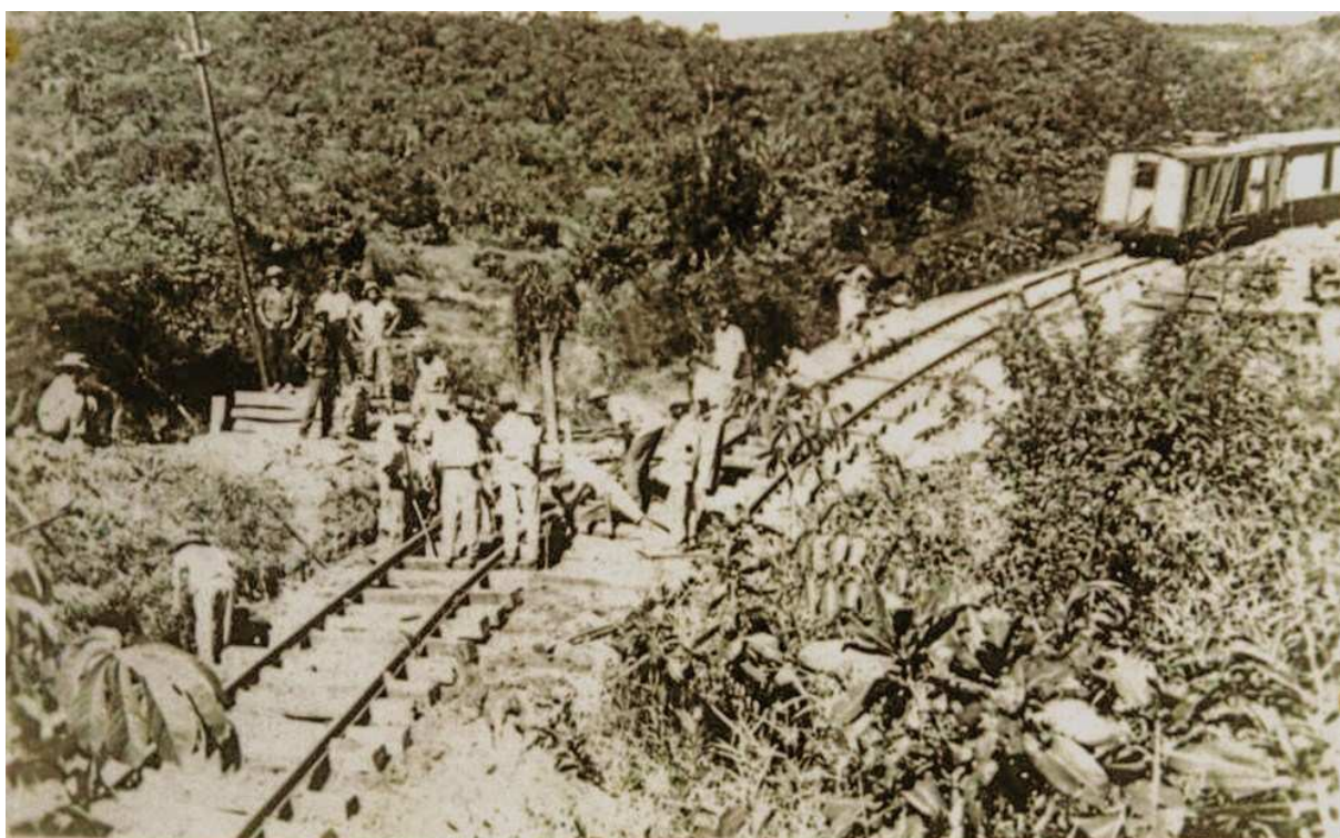
Figura 14 - O rompimento da estrada de ferro, em função de uma forte chuva, impedia a passagem dos trens, causando transtornos à movimentação de pessoas e mercadorias. (Fonte: acervo do autor).
