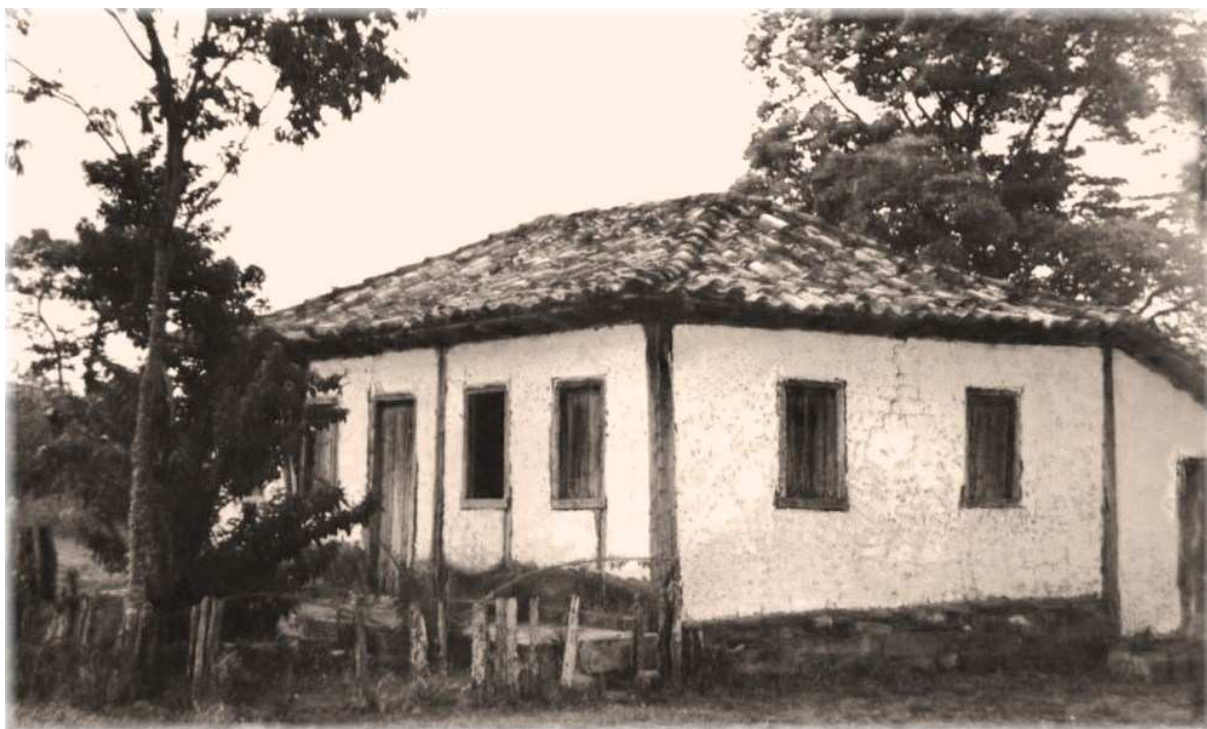
Figura 11- A sede da fazenda que pertenceu a Dulce Carneiro e Teodoro José de Souza foi demolida para venda do madeiramento. Conforme Rocha Júnior (2006) predominava o estilo arquitetônico mineiro, com o interior das casas marcado pela ausência do corredor, os cômodos interligados por portas, as janelas de madeira; em algumas, como a da foto acima, havia telhas moldadas pelos escravos. (Fonte: Acervo do autor)
