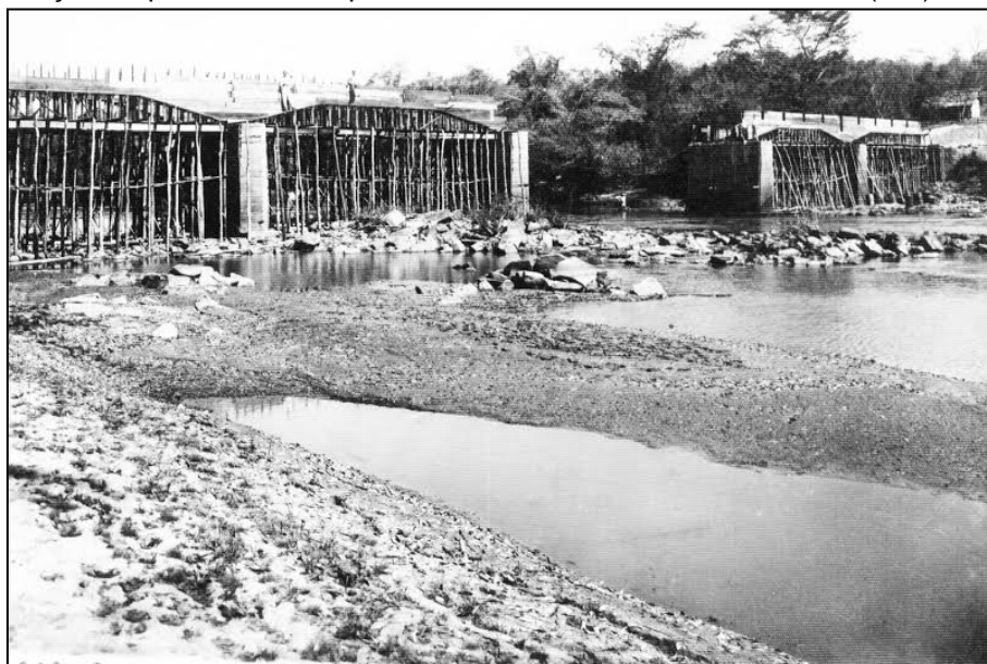
Foto 6 – Construção da ponte dos Carapinas sobre o Rio São Marcos, Catalão (GO) - década de 1950
