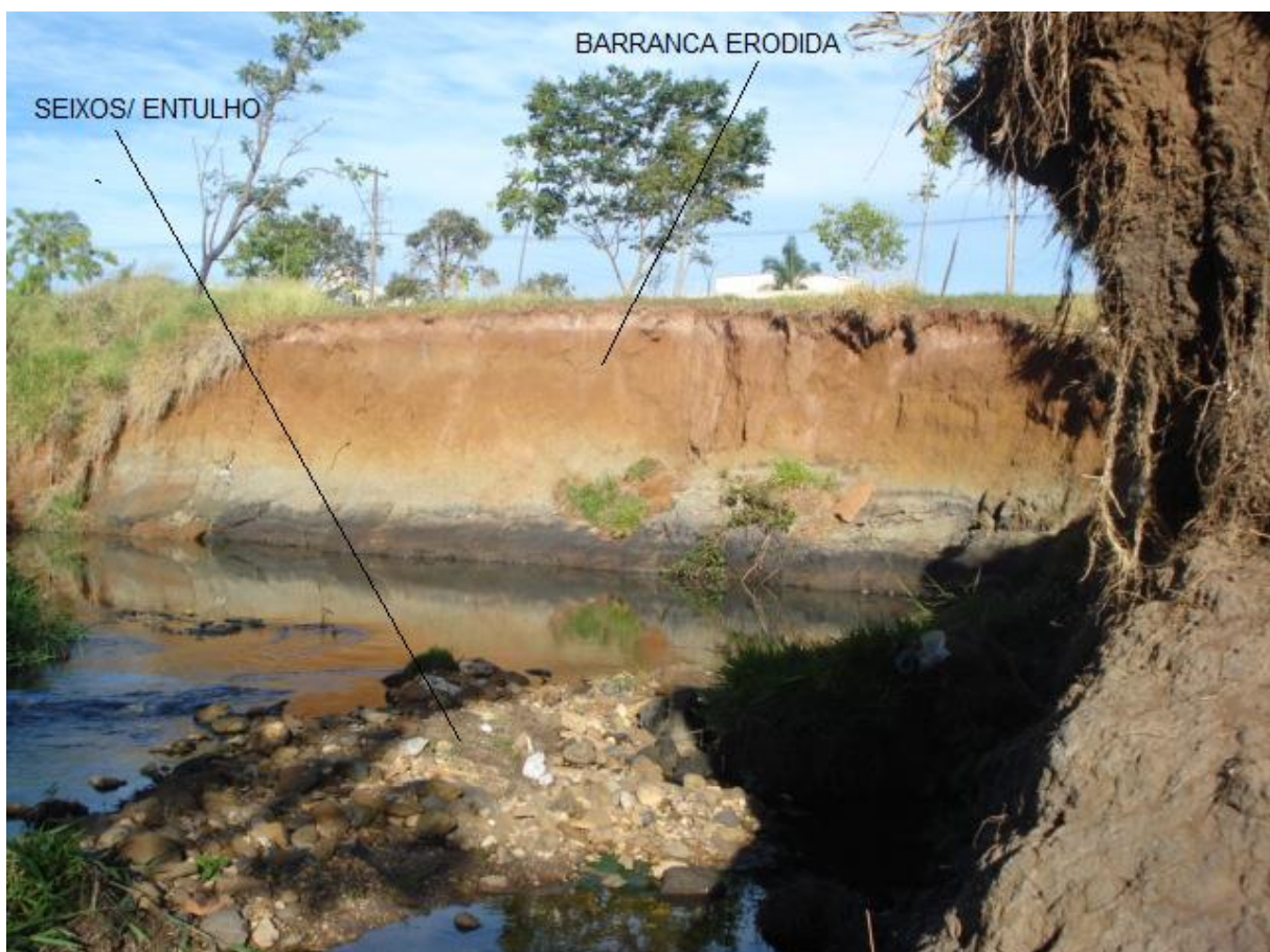
Figura 19 – Erosão no Córrego Lagoinha
