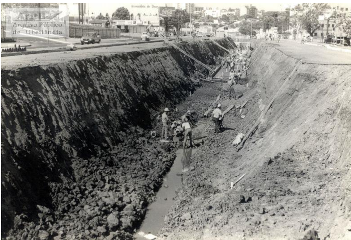
Figura 16 – Construção da galeria pluvial da Avenida Rondon Pacheco (1992)
