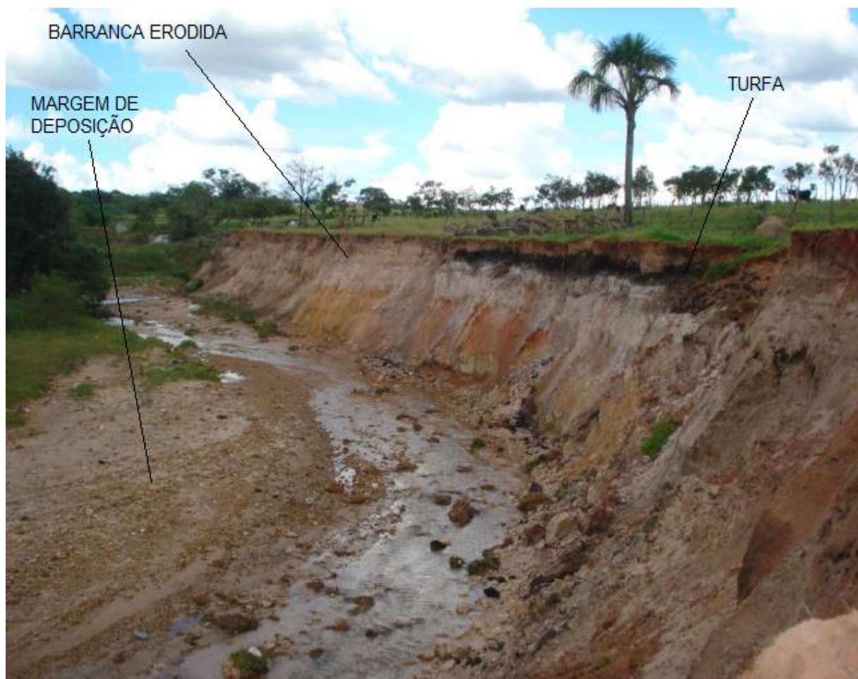
Figura 20 – Erosão no Córrego Campo Alegre
