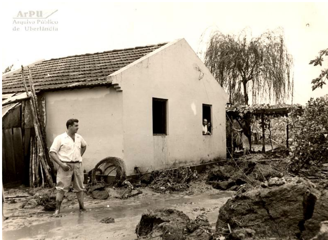
Figura 14 – Córrego Tabocas. Moradia e moradores na área de risco
