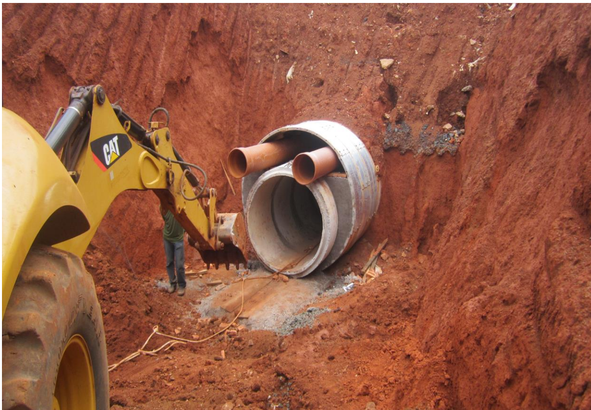
Figura 31 – Obras da rede pluvial e esgoto: Nova Alvorada
