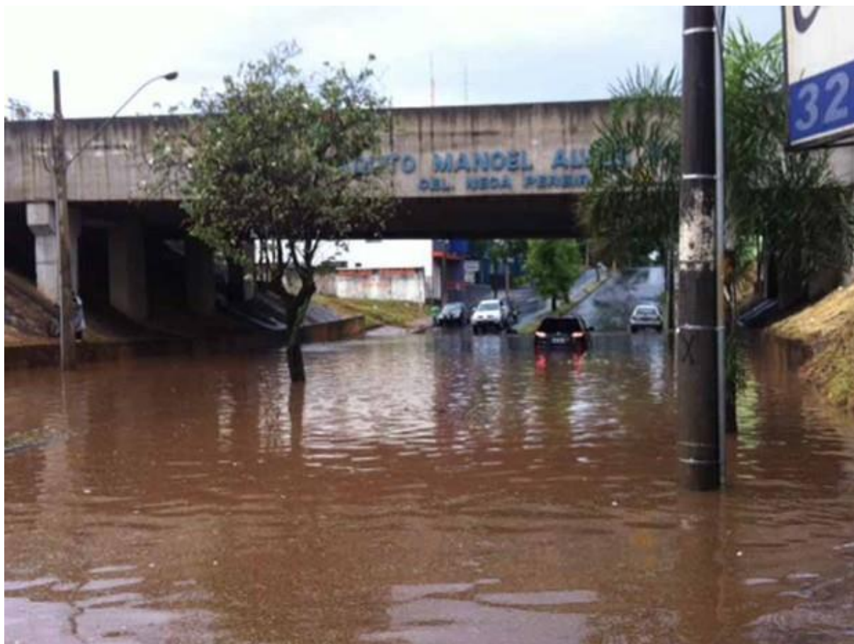
Figura 22 – Alagamento na Avenida Brasil. Bairro Brasil.
