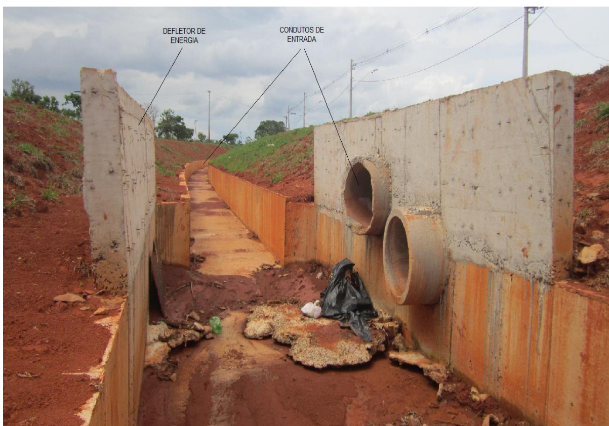
Figura 29 – Canal de escoamento pluvial: Nova Alvorada
