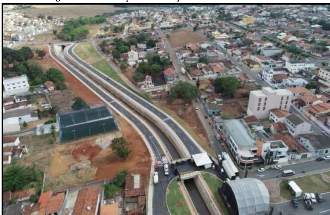
Figura 20: Última etapa da canalização em Catalão no ano de 2019
