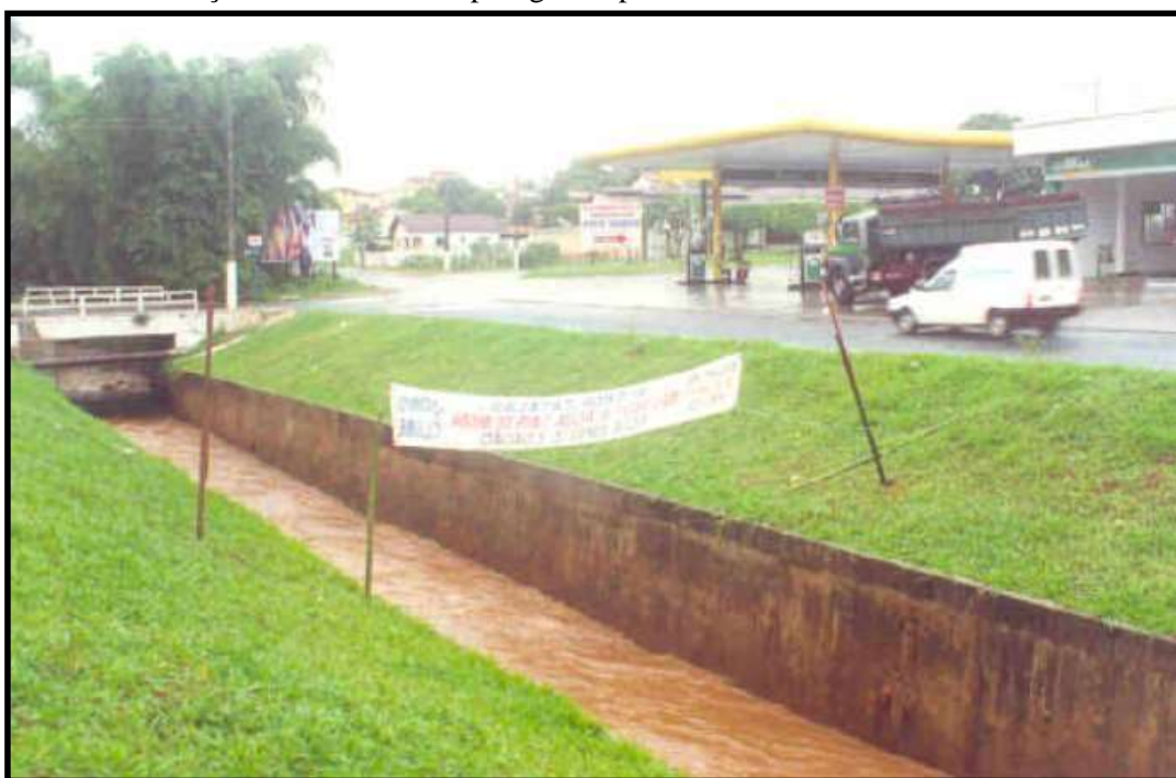
Figura 10: Canalização do Ribeirão Pirapitinga nas proximidades do Posto do Gaúcho
