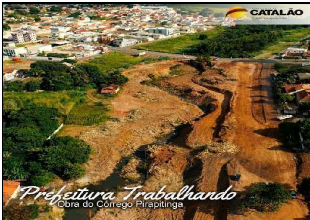
Figura 19: Vista aérea da área da nova canalização
