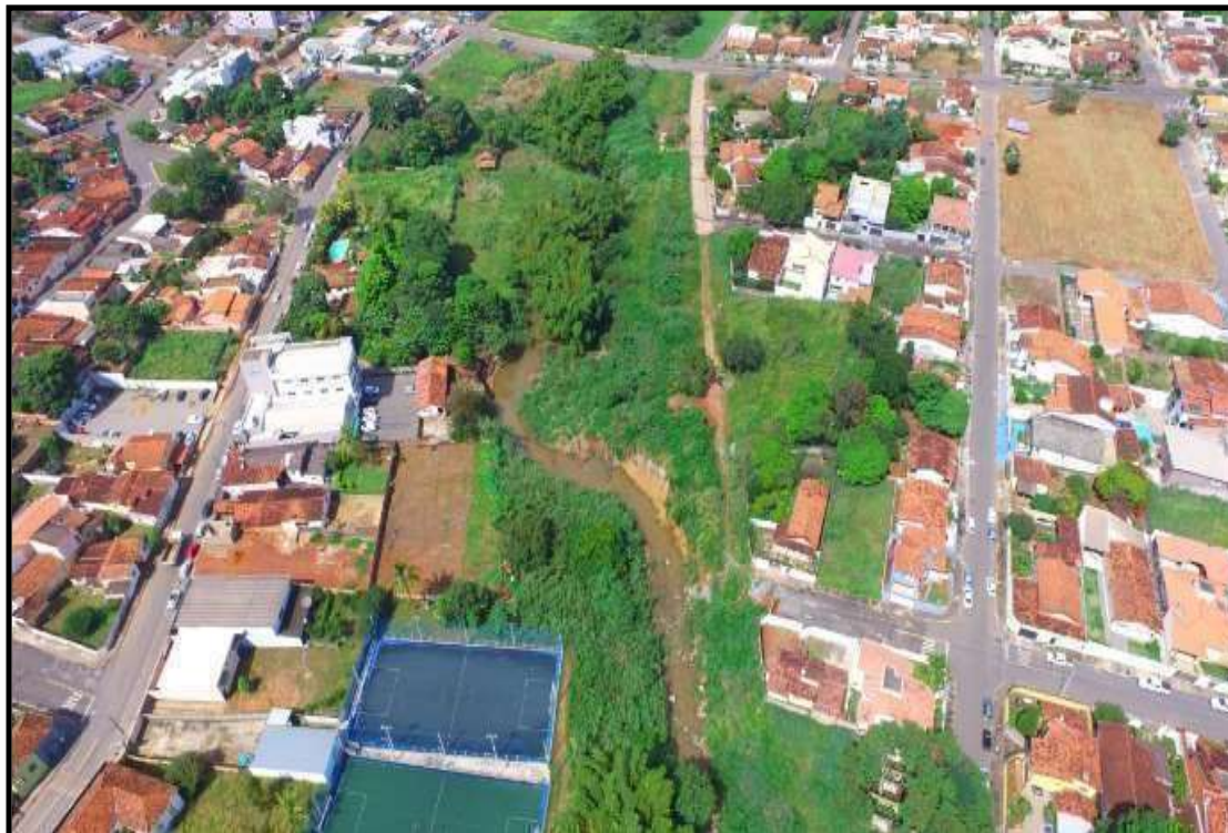
Figura 18: Vista aérea da terceira parte a ser canalizada
