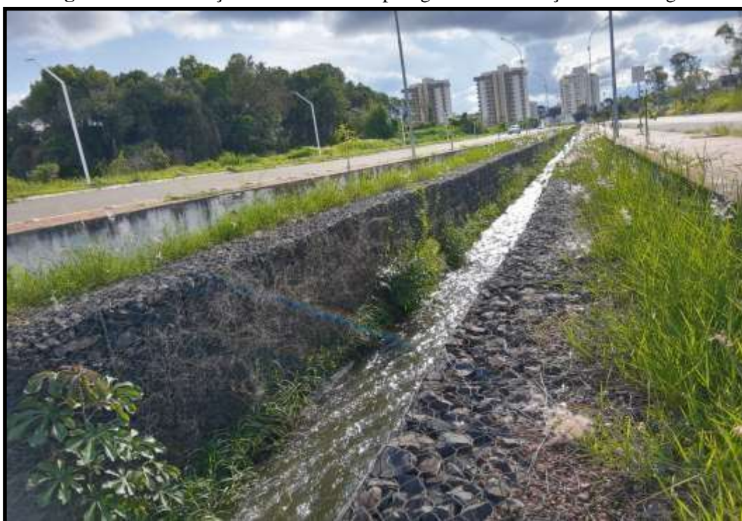
Figura 13: Canalização do Ribeirão Pirapitinga com a utilização de caixas gabiões
