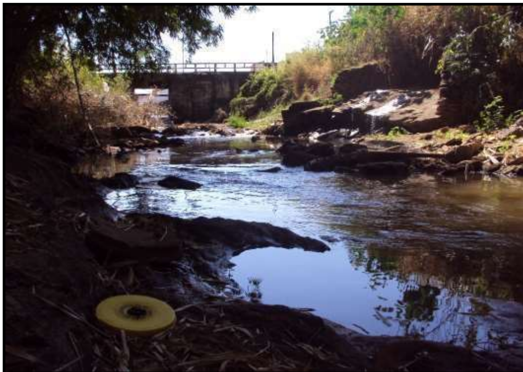
Figura 15: Área ao final da canalização no ano de 2018
