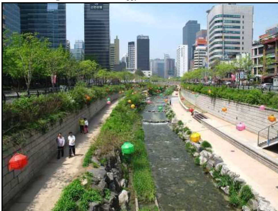
Figura 22: Rio Cheonggye Cheon revitalizado
