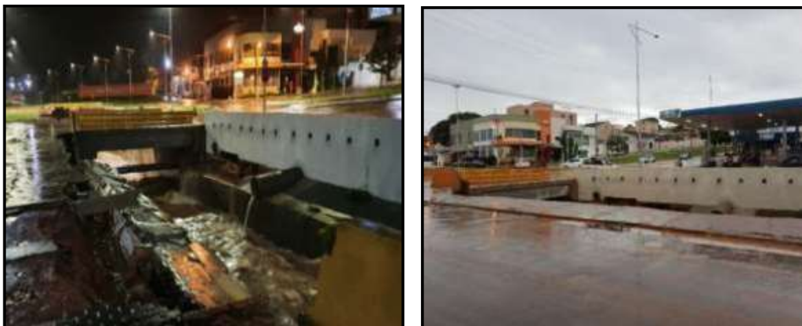
Figuras 35 e 36: Estrutura da canalização após a chuva
