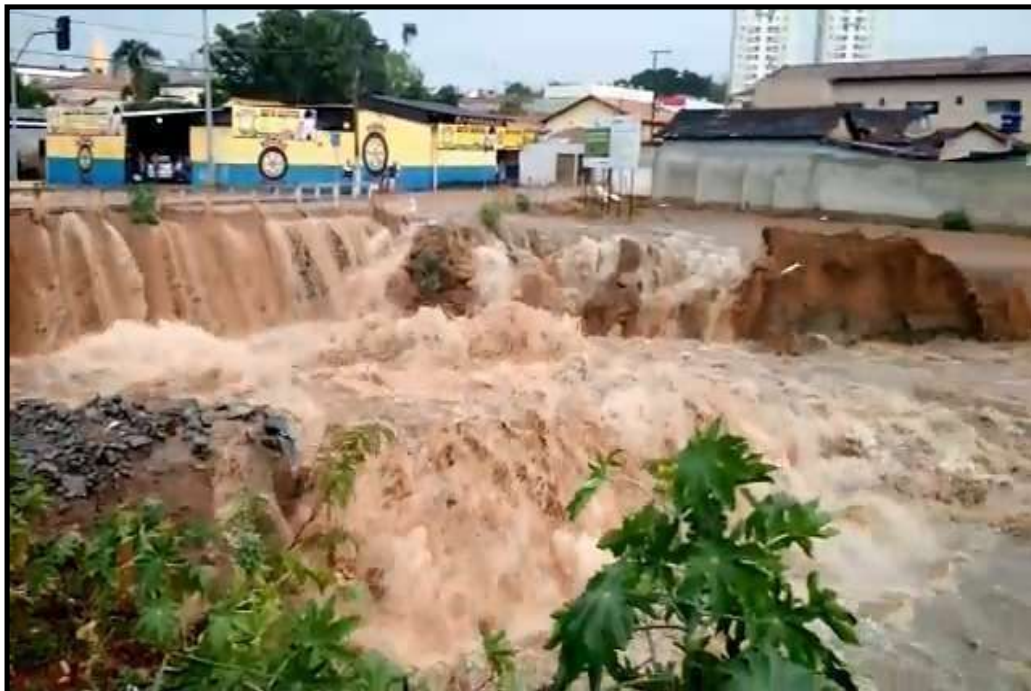
Figura 16: Área ao final da canalização durante chuva no ano de 2019
