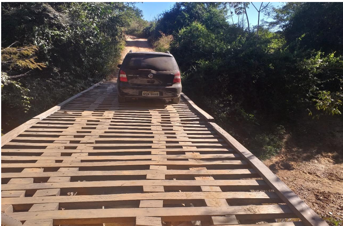
Figura 4 - Ponte de madeira (12m.), sobre o Córrego da Nascente dentro do Assentamento Olga Benário
