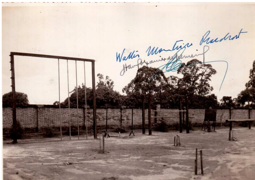
Figura 22: Instalações de Educação Física.
