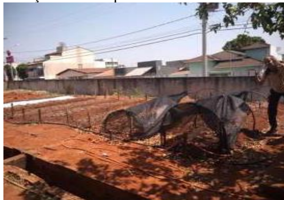
Figura 26: Construção da horta pelo NEPEA no CEPMG em Catalão (GO)
