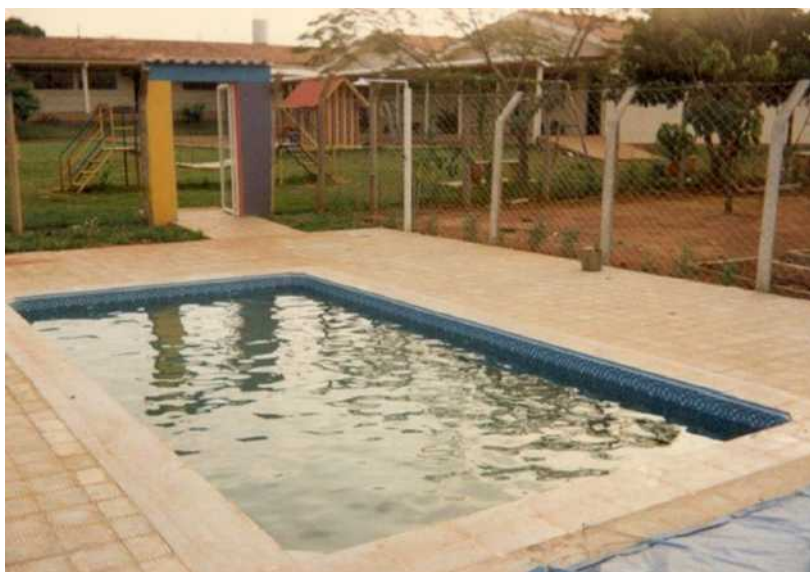
Figura 19 – Área da Piscina recém-construída – Ano de 1996 – Escola Santa Clara de Catalão.
