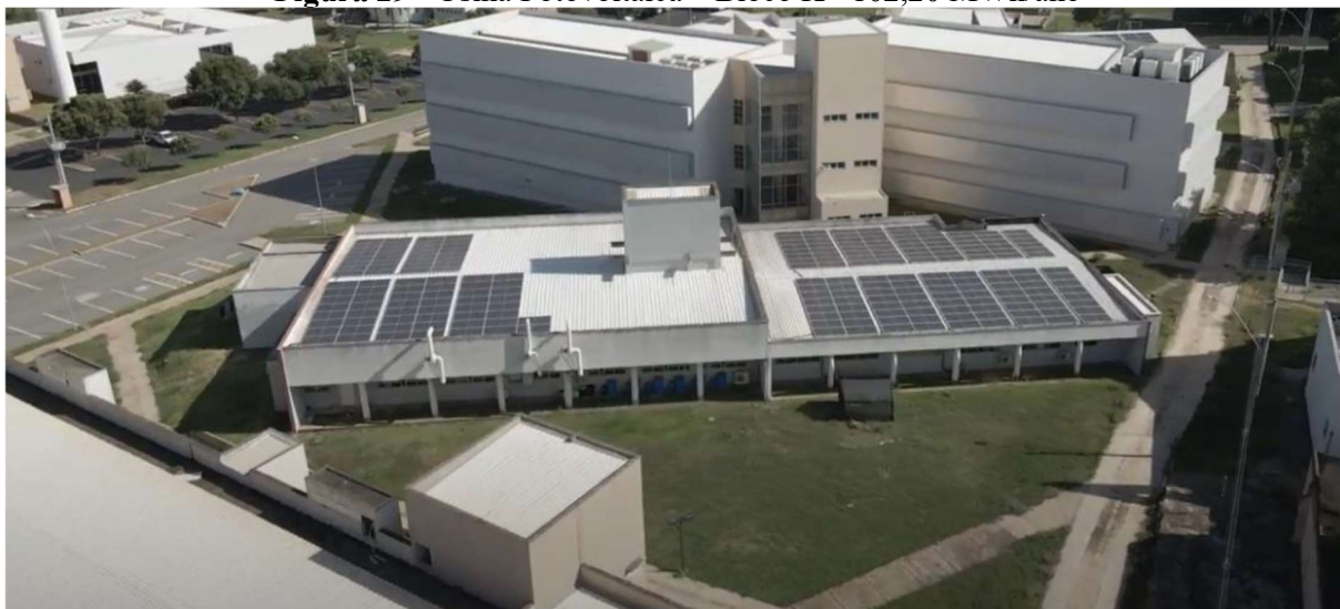
Figura 29 - Usina Fotovoltaica – Bloco K - 102,20 MWh/ano
