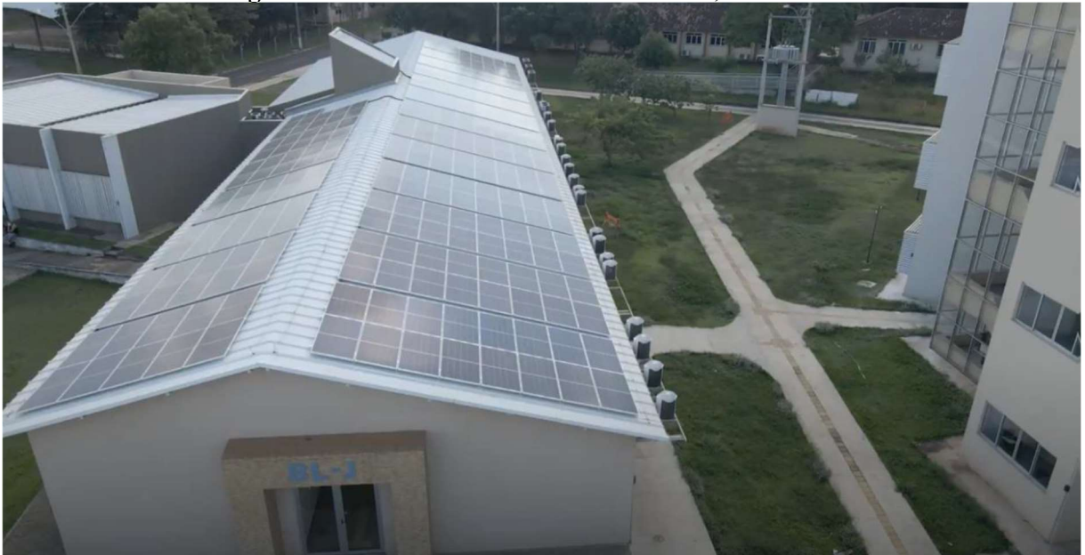
Figura 28 - Usina Fotovoltaica - Bloco J - 127,75 MWh/ano
