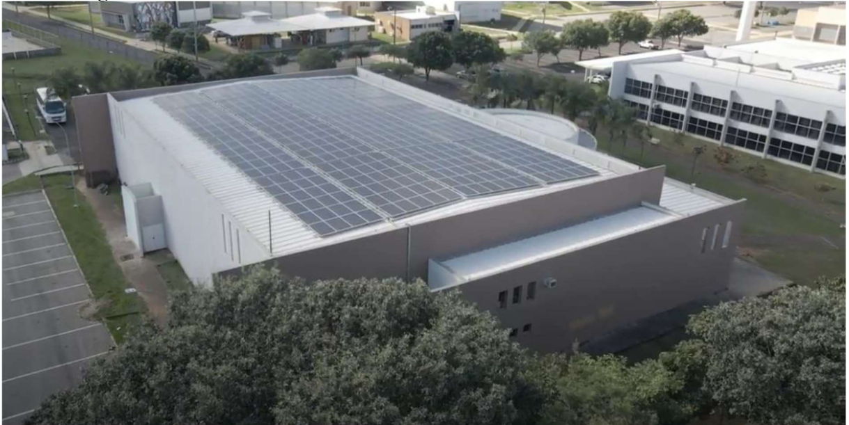
Figura 27 - Usina Fotovoltaica - Auditório Paulo Bastos Perillo – 127,75 MWh/ano
