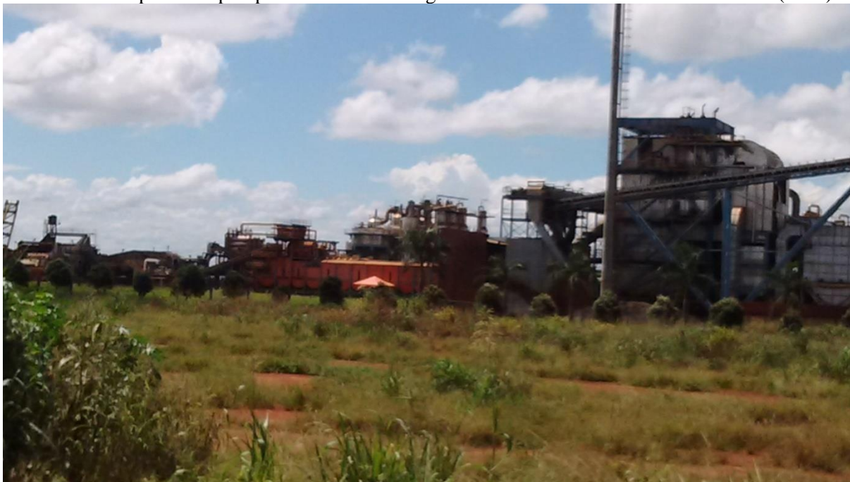
Foto 9 – Município de Capinópolis: abandono da agroindústria canavieira Vale do Paranaíba (2016).
