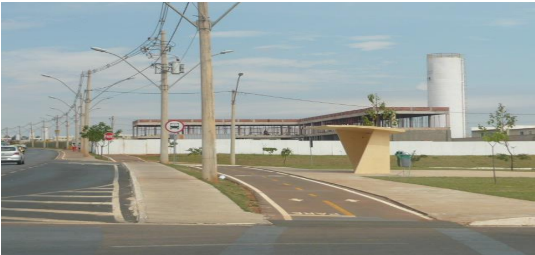
Foto 46 - Avenida central do bairro Jardins Mangueiral (DF): construção do posto de abastecimento – 2014.
