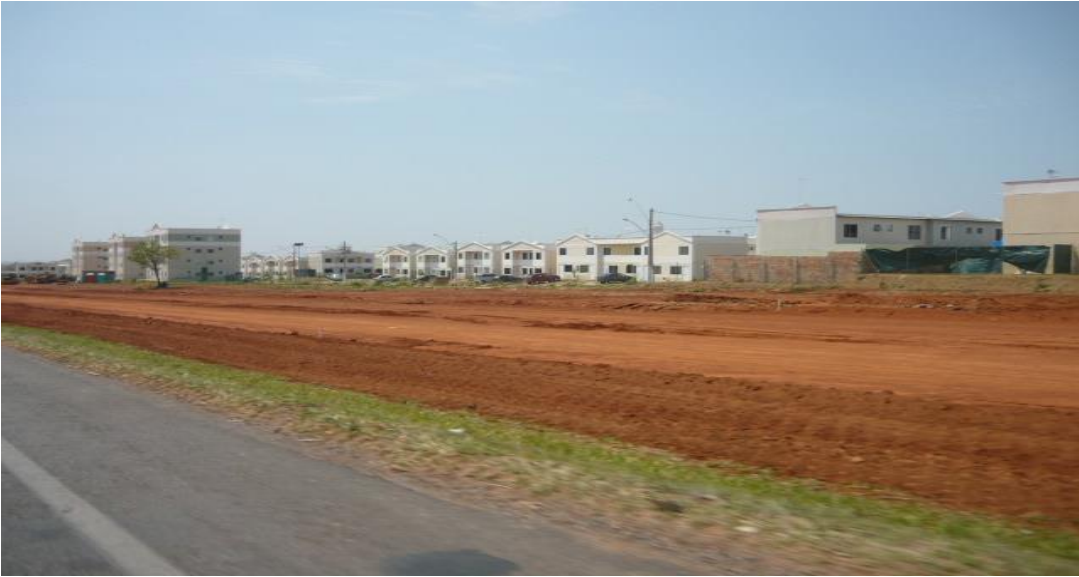
Foto 45 – São Sebastião (DF): duplicação da DF-463 – 2014.
