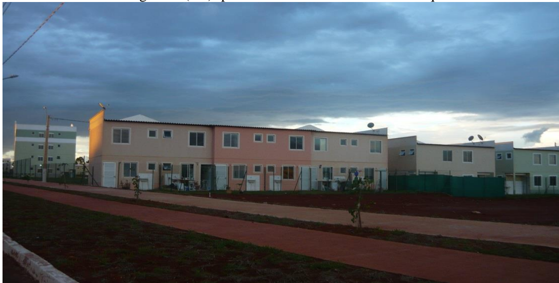
Foto 42 - Jardins Mangueiral (DF): parte dos fundos das casas de dois quartos – 2014.
