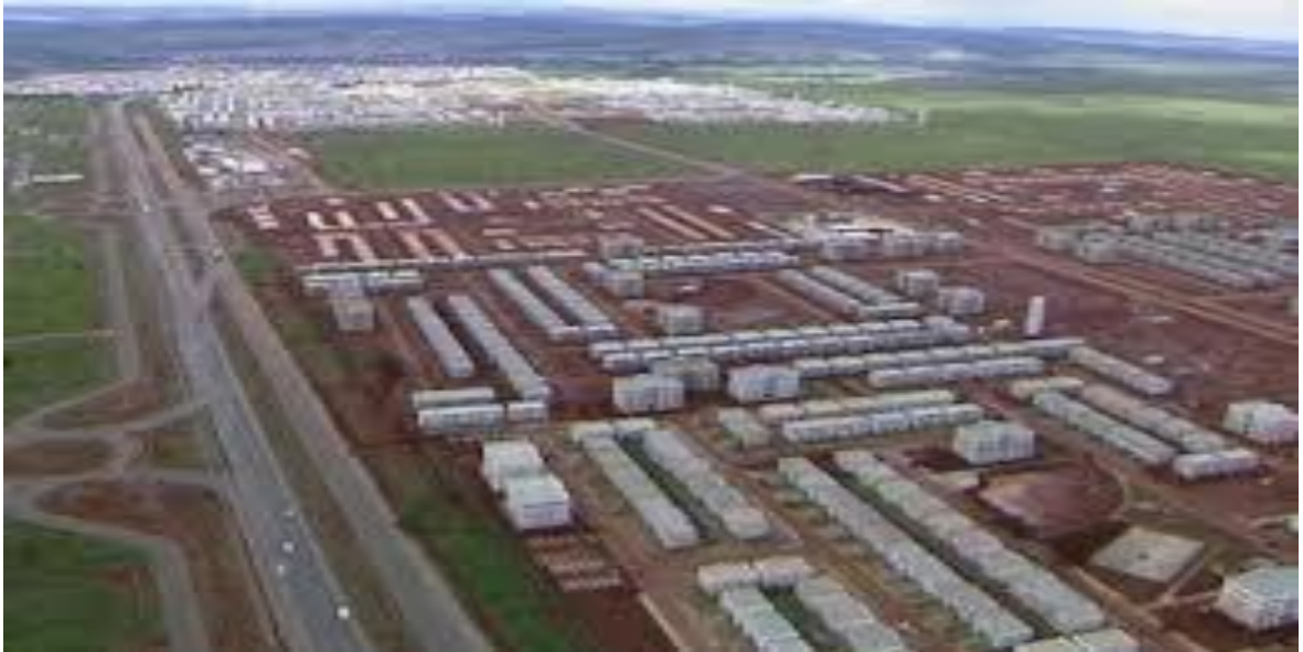
Foto 13 - Imagem aérea do bairro em construção – Jardins Mangueiral – 2011.
