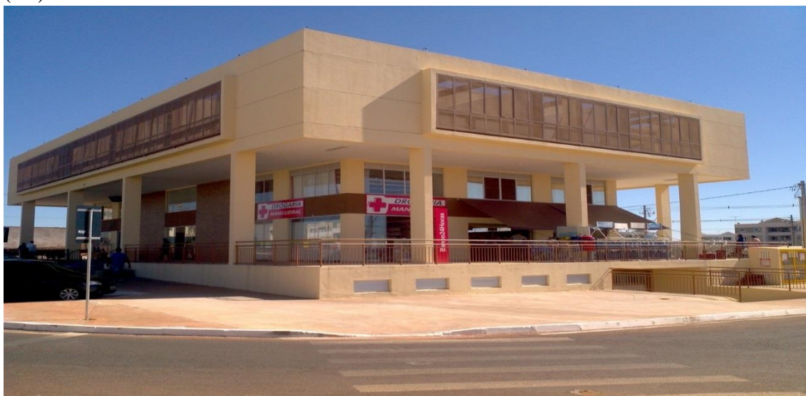
Foto 35 - o prédio comercial do bairro: mercado, drogaria e salão de beleza, Jardins Mangueiral (DF) – 2014.
