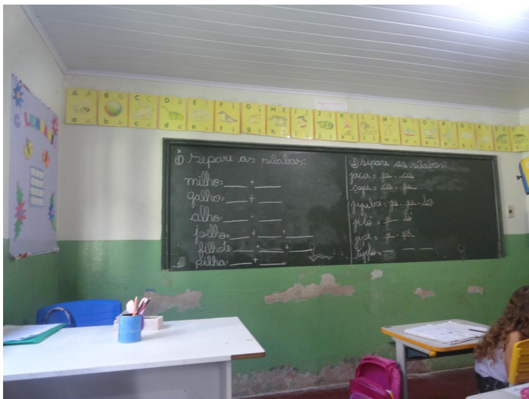
Foto 8 – Sala de aula
