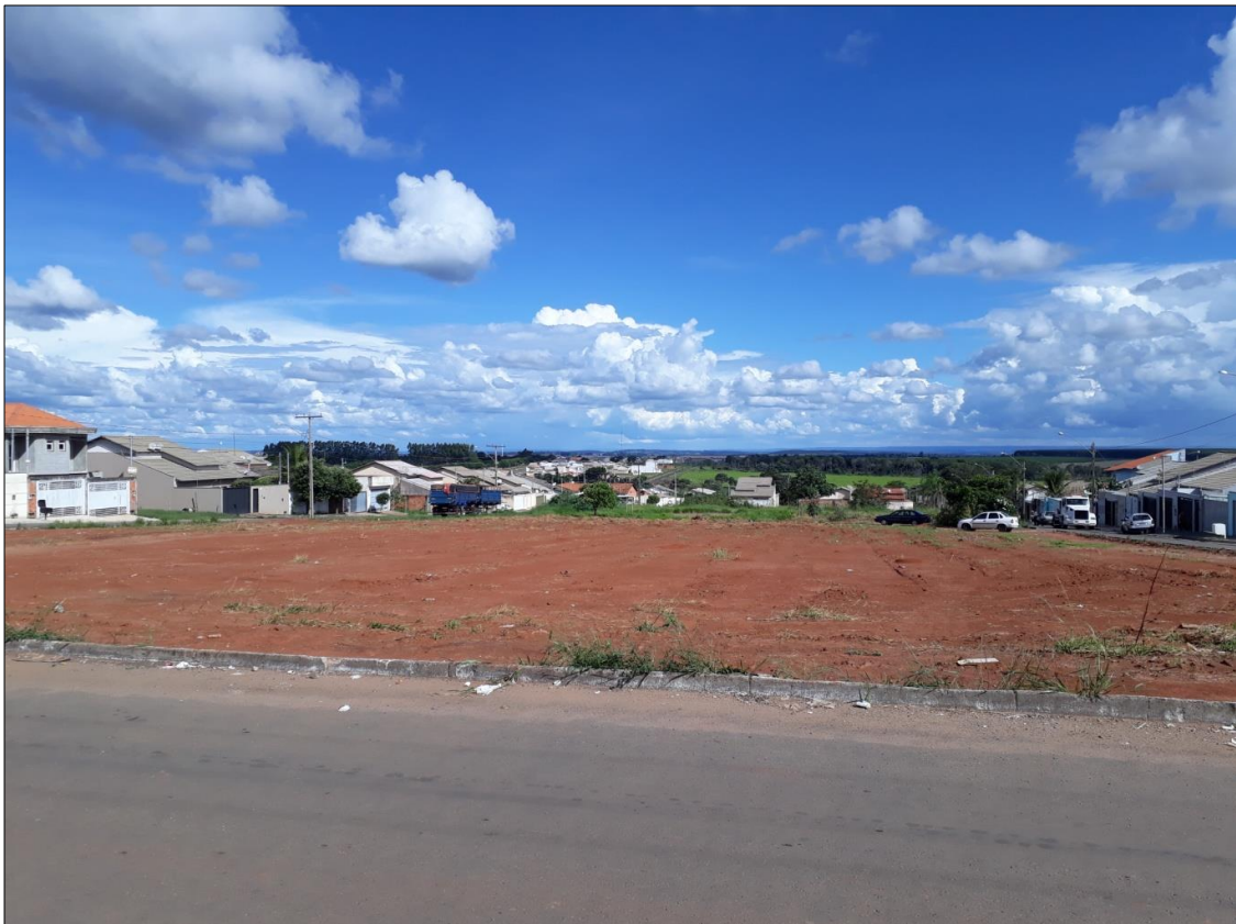
Foto 2 - Quadra destinada à construção da Praça do bairro Estrela, em Catalão (GO) – 2019
