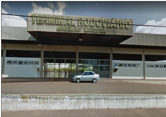
Figura 5 - Frente do Terminal Rodoviário de Monte Carmelo/MG
