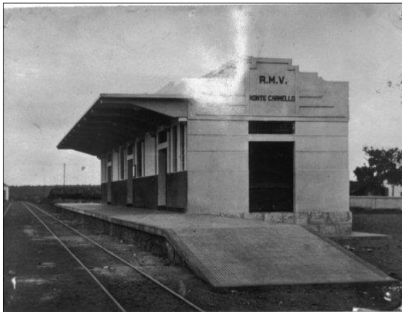
Figura 13 - Estação Ferroviária de Monte Carmelo (MG) em 1960.
