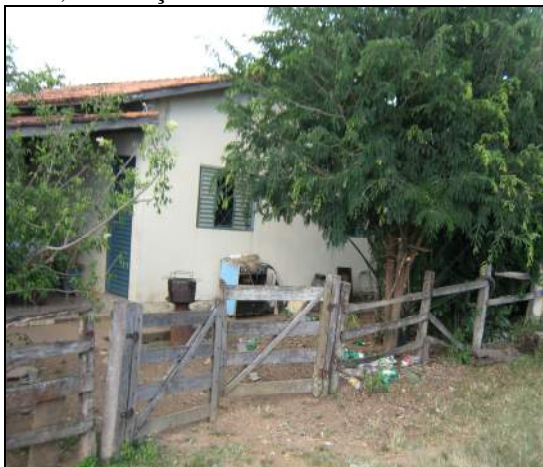
Foto 18 - comunidade Anta Gorda, Catalão (GO): 2014; construção de casa.
