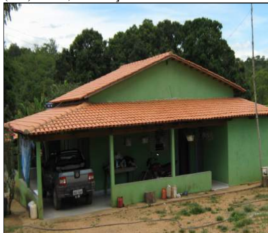
Foto 19 - comunidade Anta Gorda, Catalão (GO): 2014; construção de casa.
