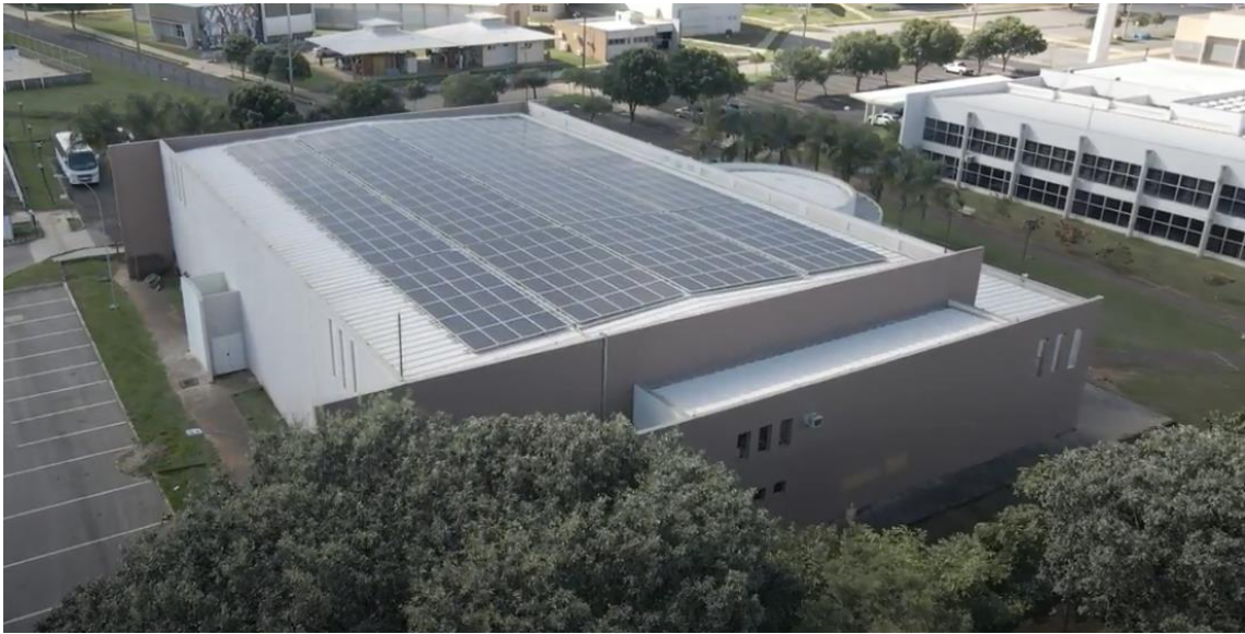
Figura 24 - Usina Fotovoltaica - Auditório Paulo Bastos Perillo – 127,75 MWh/ano.
