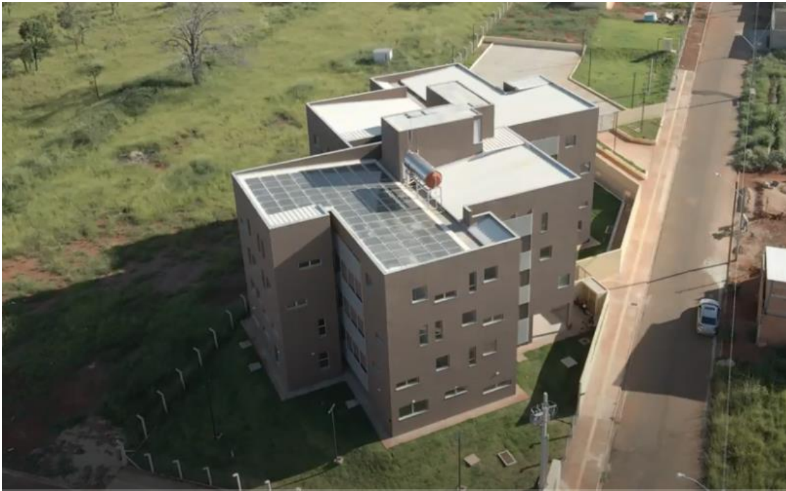
Figura 28 - Placas de Aquecimento Solar MUC.
