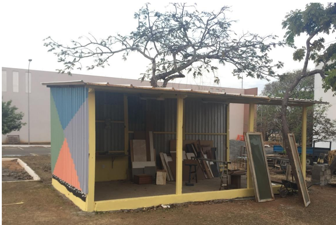
Figura 31 – Estação de Pintura – Vista 2
