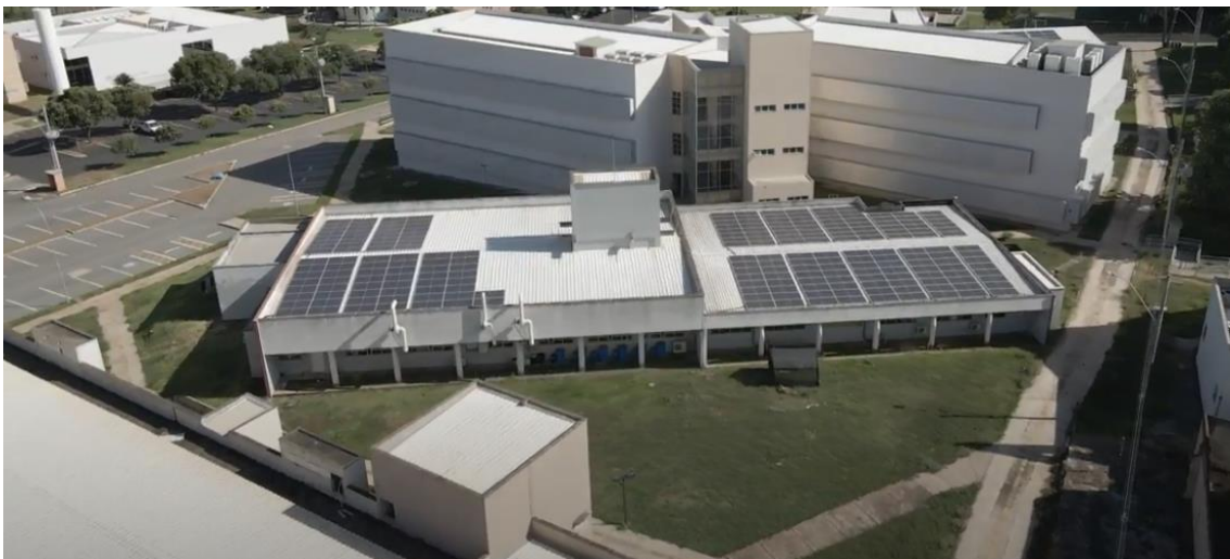
Figura 27 - Usina Fotovoltaica – Bloco K - 102,20 MWh/ano.
