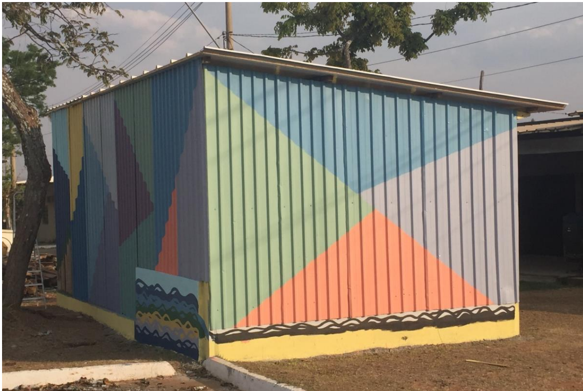
Figura 30 - Estação de Pintura – Vista 1
