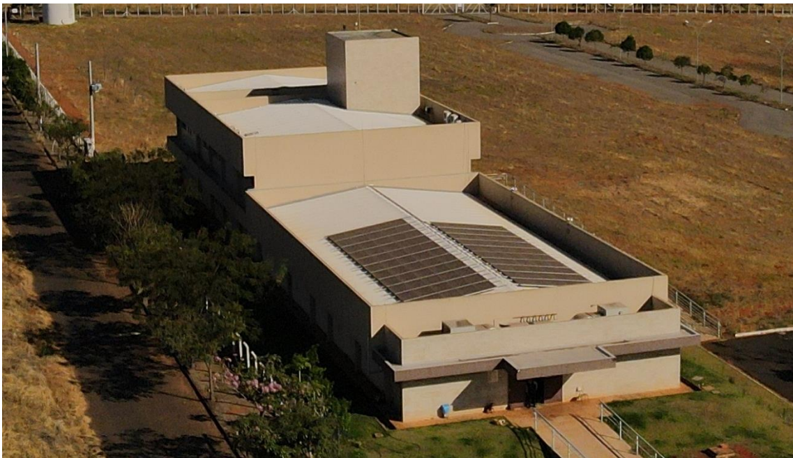
Figura 25 - Usina Fotovoltaica – Bloco B – Campus 2 – 31,93 MWh/ano.
