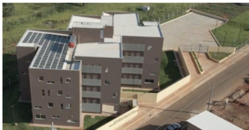
Figura 1: Fachada da Moradia Universitária do Cerrado (UFCAT).
