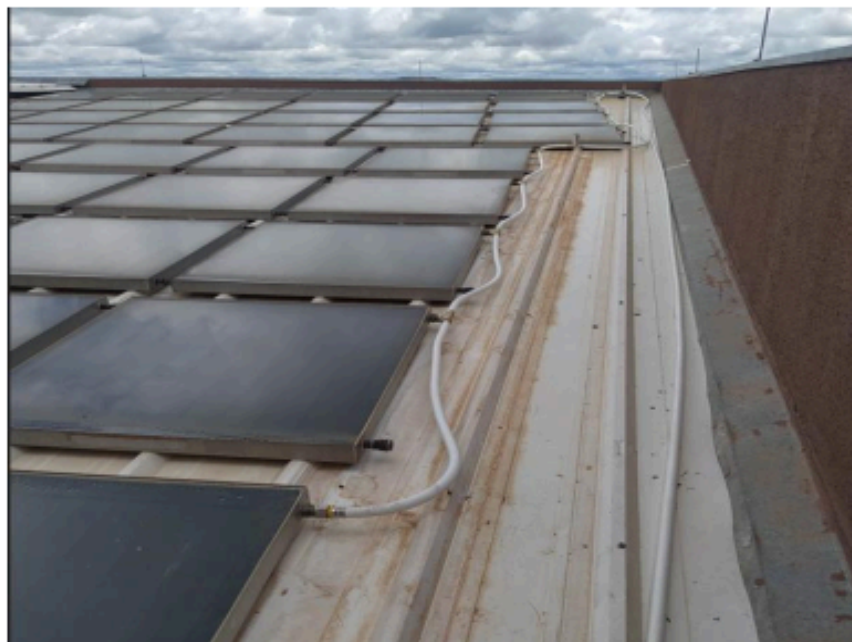
Figura 4: Nova tubulação em PEX, instalada.
