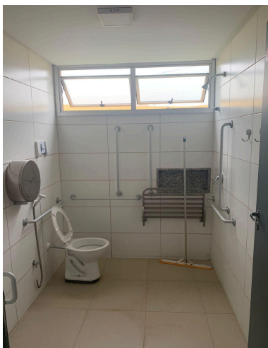
Figura 8 - Banheiro no pavimento térreo.
