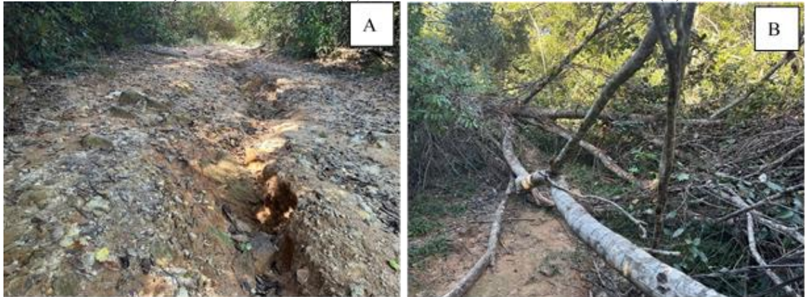
Fotografia 8 - Condições adversas da estrada de acesso à Cachoeira da Usina, em visita em maio de 2023. Presença de ravinas erosivas (A) em trechos declivosos e árvores caídas (B).
