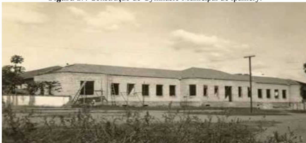
Figura 17: Construção do Gymnasio Municipal de Ipamery.
