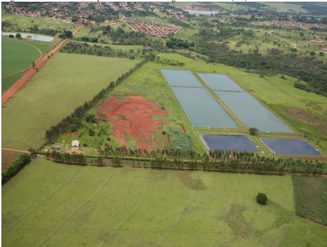
Figura 14: Vista aérea da Estação de Tratamento de Esgoto de Morrinhos (GO).
