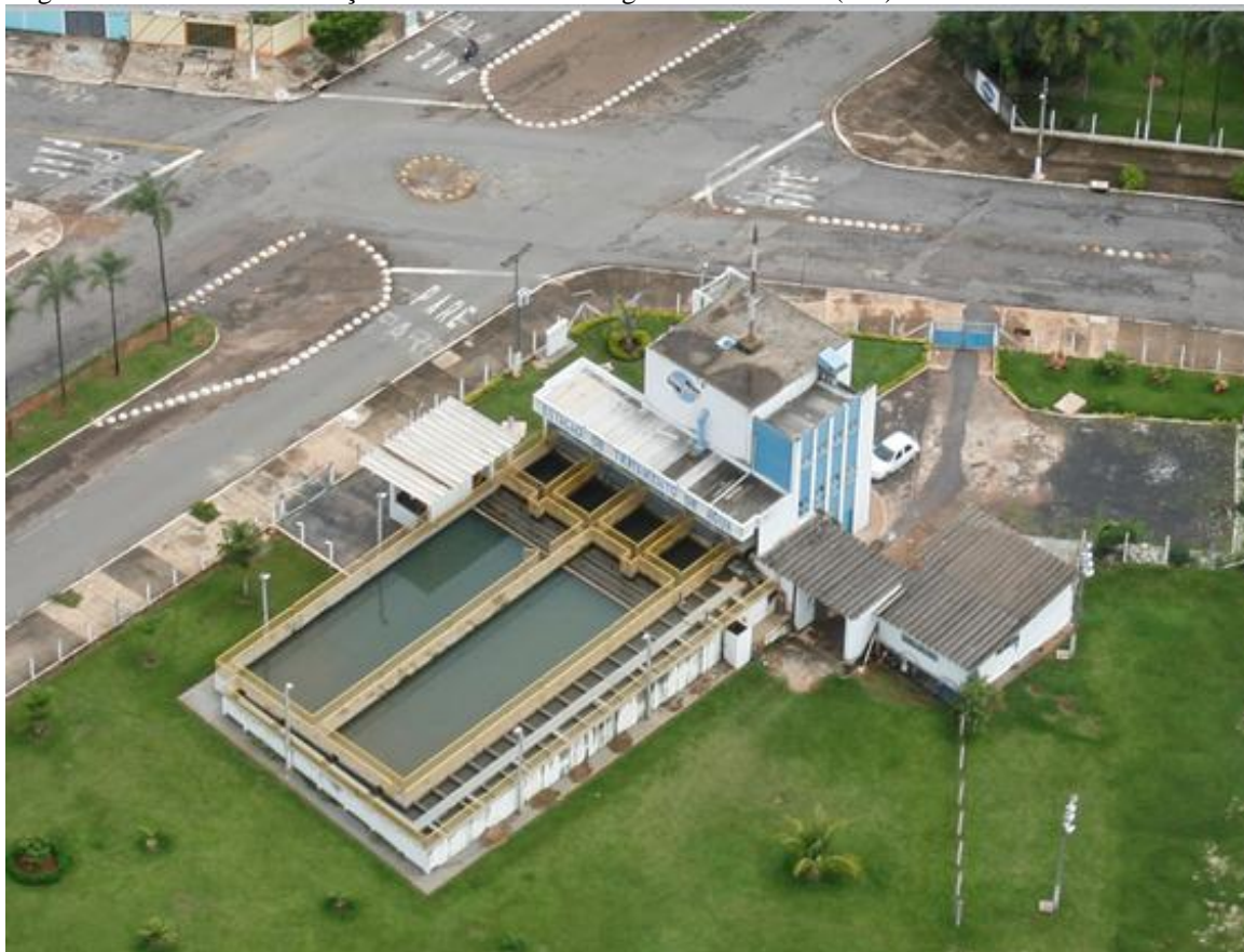
Figura 4: Vista aérea da Estação de Tratamento de Água de Morrinhos (GO).
