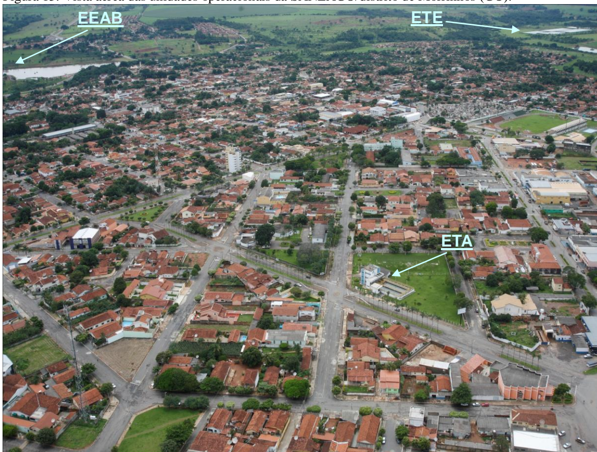
Figura 15: Vista aérea das unidades operacionais da SANEAGO/distrito de Morrinhos (GO).
