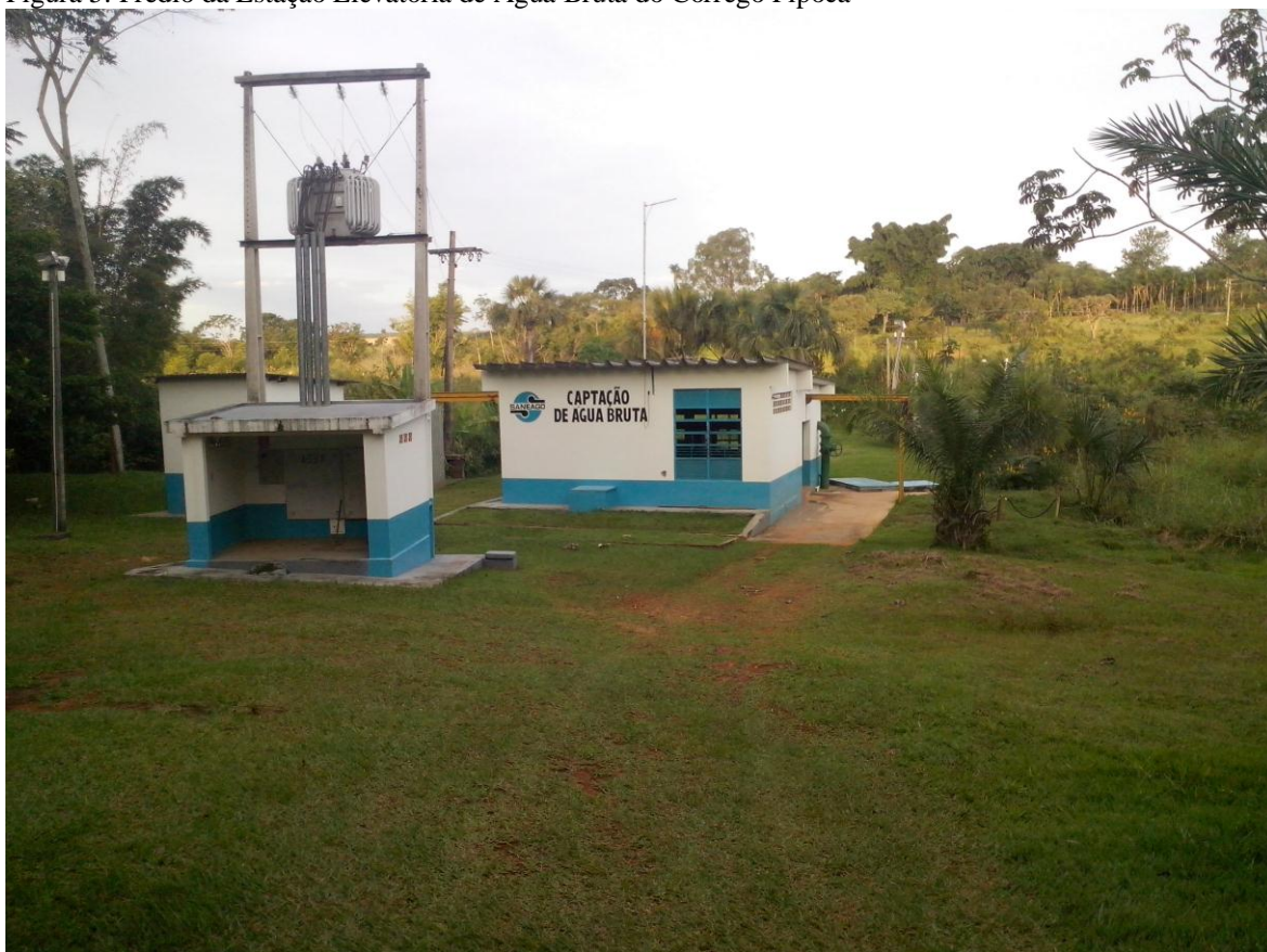
Figura 5: Prédio da Estação Elevatória de Água Bruta do Córrego Pipoca
