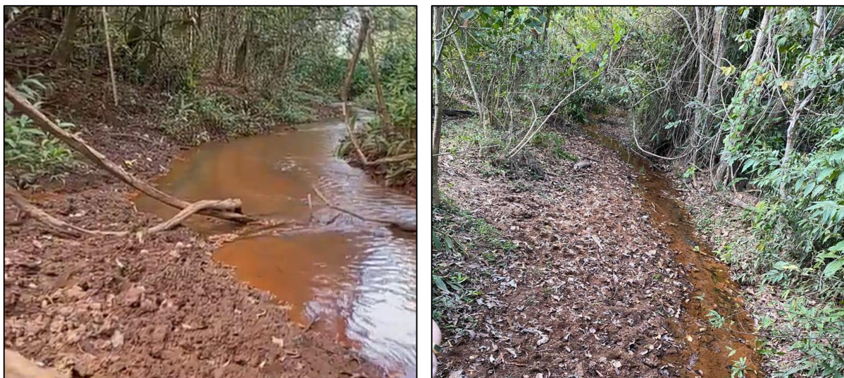
Fotografia 21. Leito de drenagem assoreada e pisoteada pelo gado bovino.
